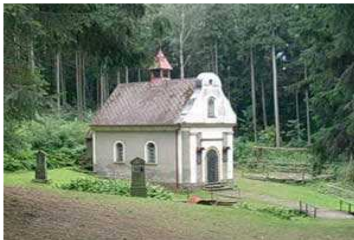
obr. č. 61 Poutní kaple nedaleko Božanovské obce Zdroj: http://www.diecezchk.cz/archiv/pannamaria/ foto: Milan Kučera
