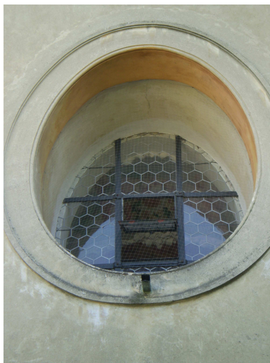
obr. č. 54 Detail oválného okna fotografie L. Švecová
