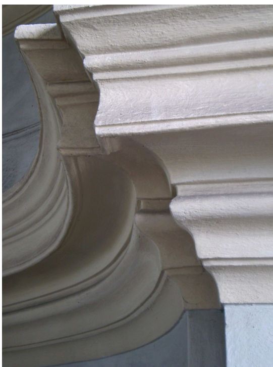
obr. č. 33 Detail římsy fotografie L. Švecová
