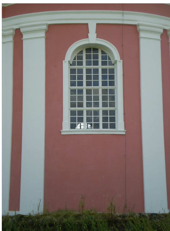
obr. č. 24 Detail zaobleného okna s klenákem u božanovského kostela fotografie L. Švecová
