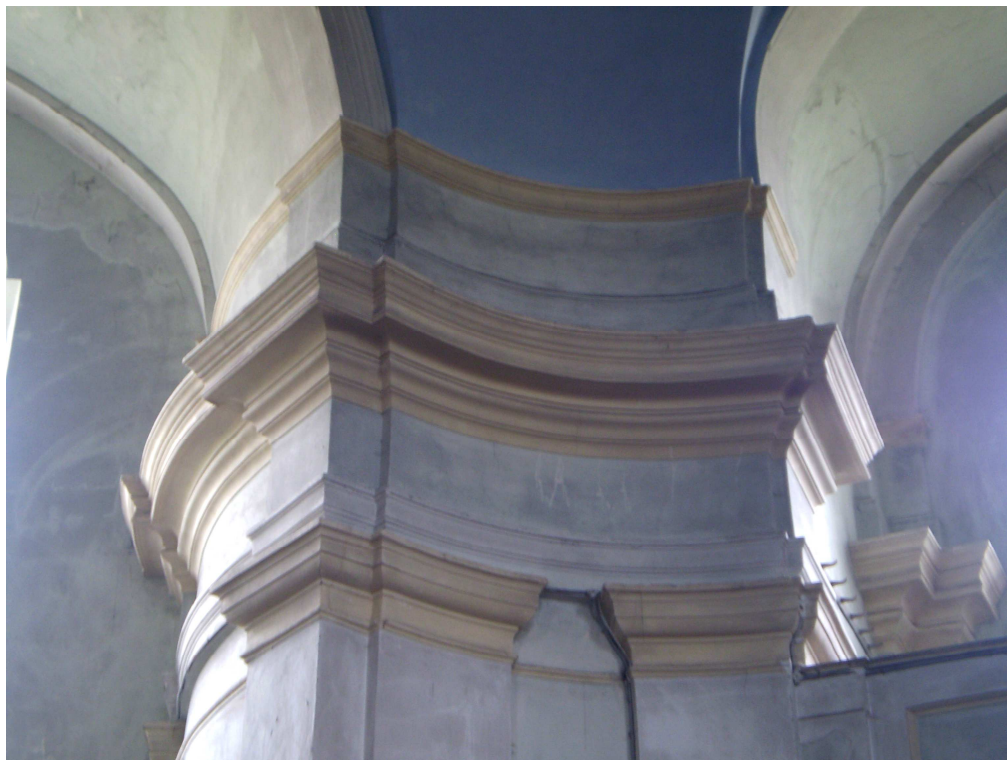
obr. č. 42 Detail pilastru a římsy fotografie L. Švecová
