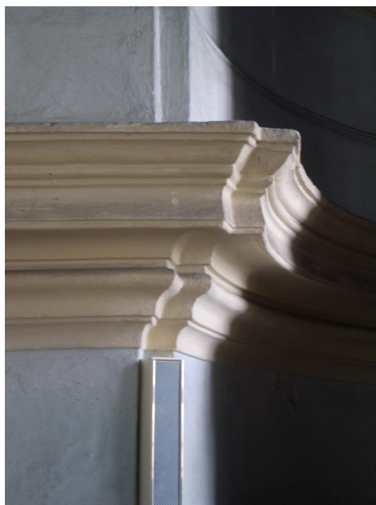
obr. č. 34 Detail římsy fotografie L. Švecová
