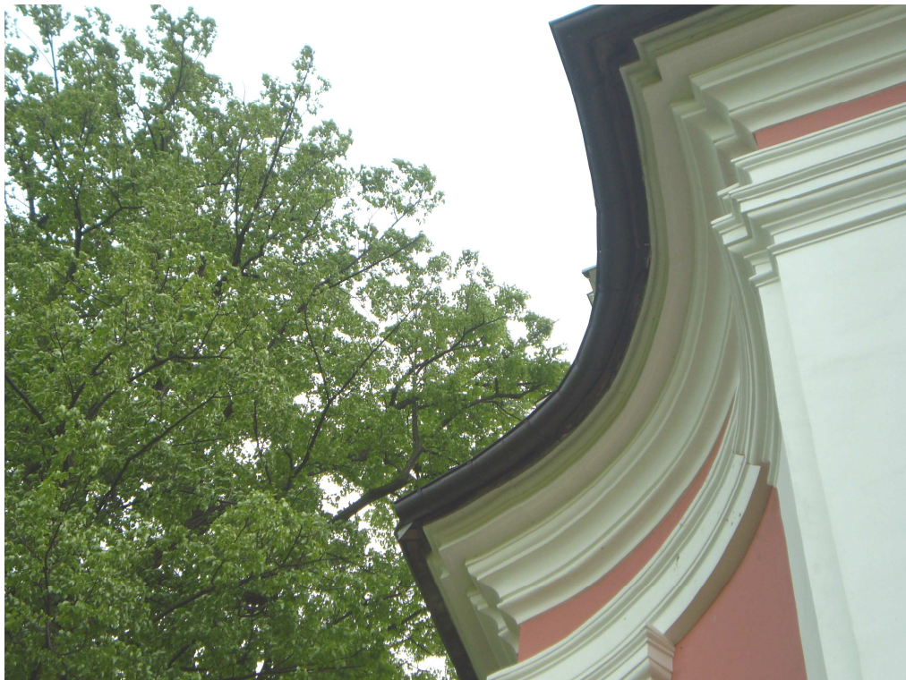
obr. č. 22 Detail korunní římsy fotografie L. Švecová
