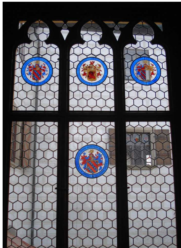
Obr. 27 : Současný stav vitrážového okna v Křížácké galerii v Rožmberku nad Vltavou
