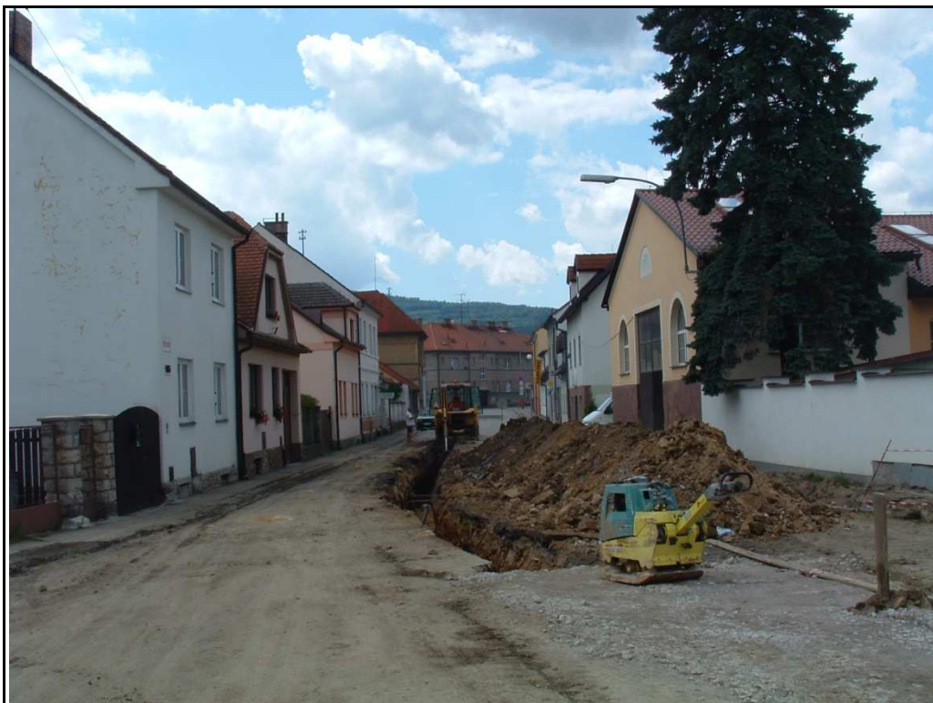
Obr. 59 – Pokládka nových inženýrských sítí ve Křemži. Foto RMČK.
