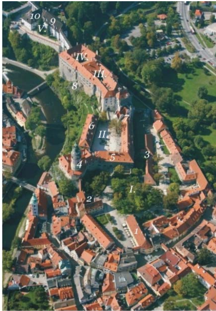
Obr. 12. Letecký snímek zámku v Českém Krumlově s vyznačením jednotlivých částí areálu
