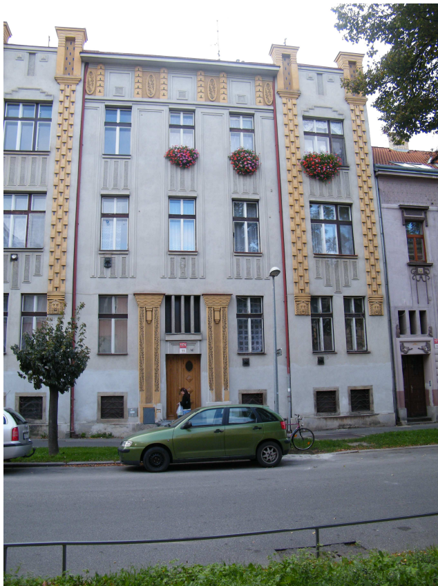
39/ Nájemní dům v Resslově ulici č. 11
