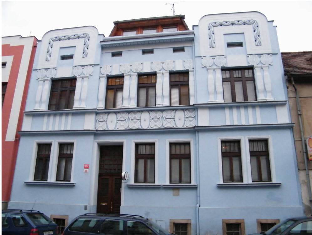
46/ Nájemní dům v Otakarově ulici č. 38
