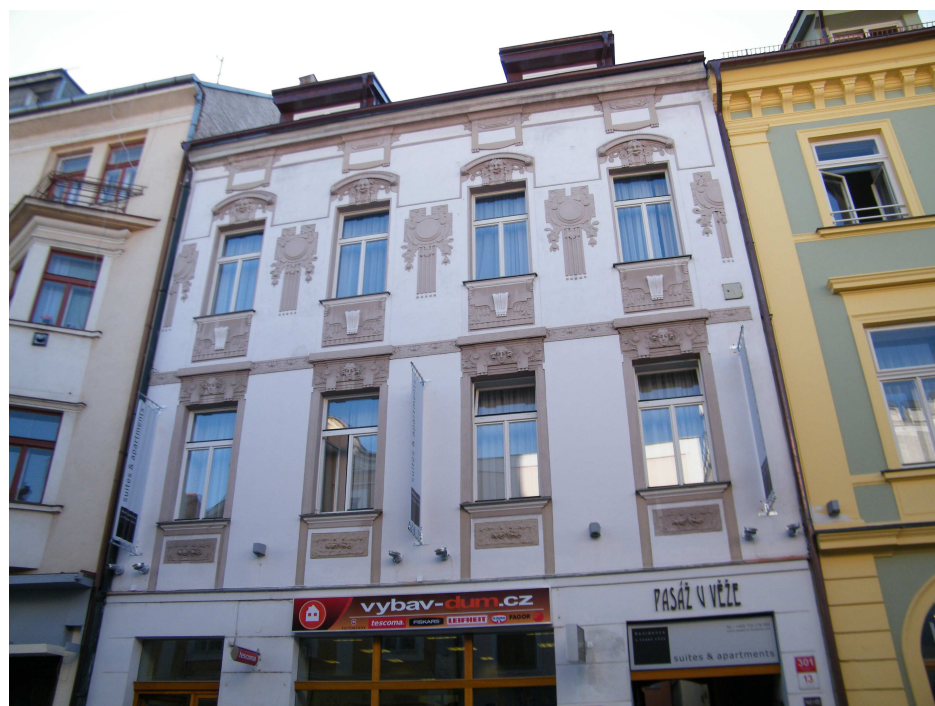
15/ Nájemní dům v ulici U Černé věže č. 13
