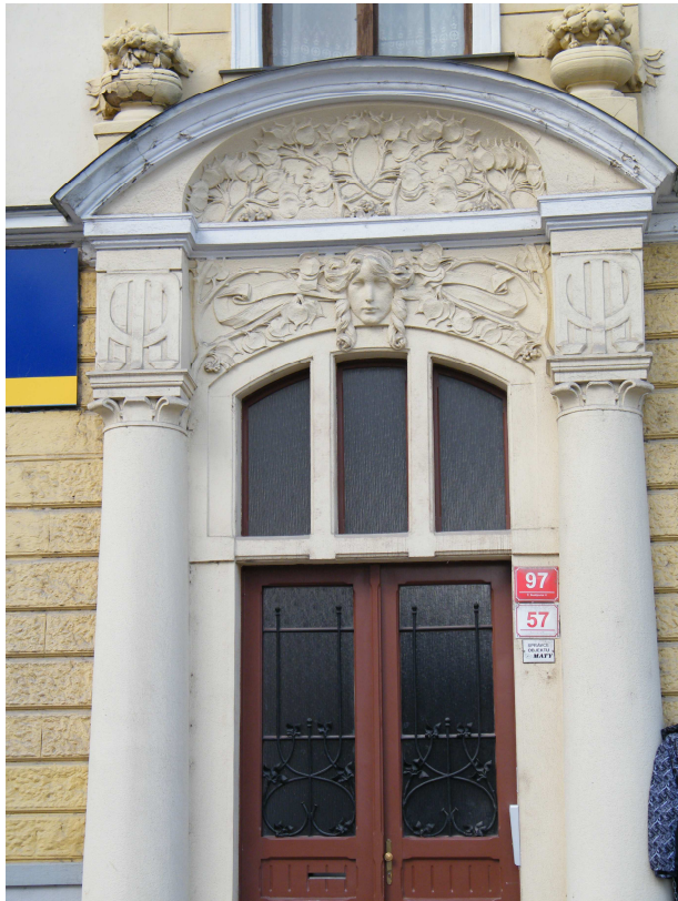
38/ Detail portálu nájemního domu na Lannově třídě č. 57
