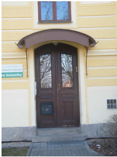
55/ Vila Isa; detail vstupních dveří s markýzou
