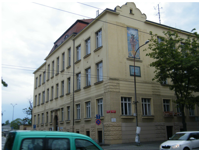
22/ Česká obchodní škola v Resslově ulici č. 1
