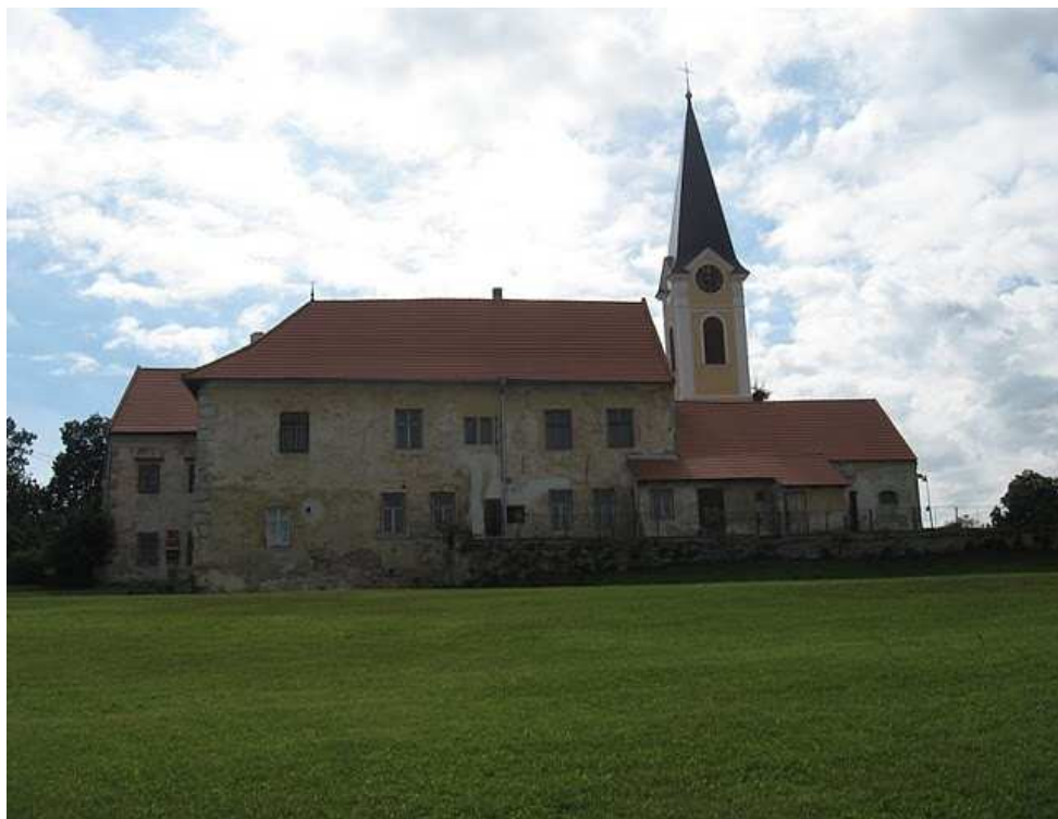
Celkový pohled na kostel
