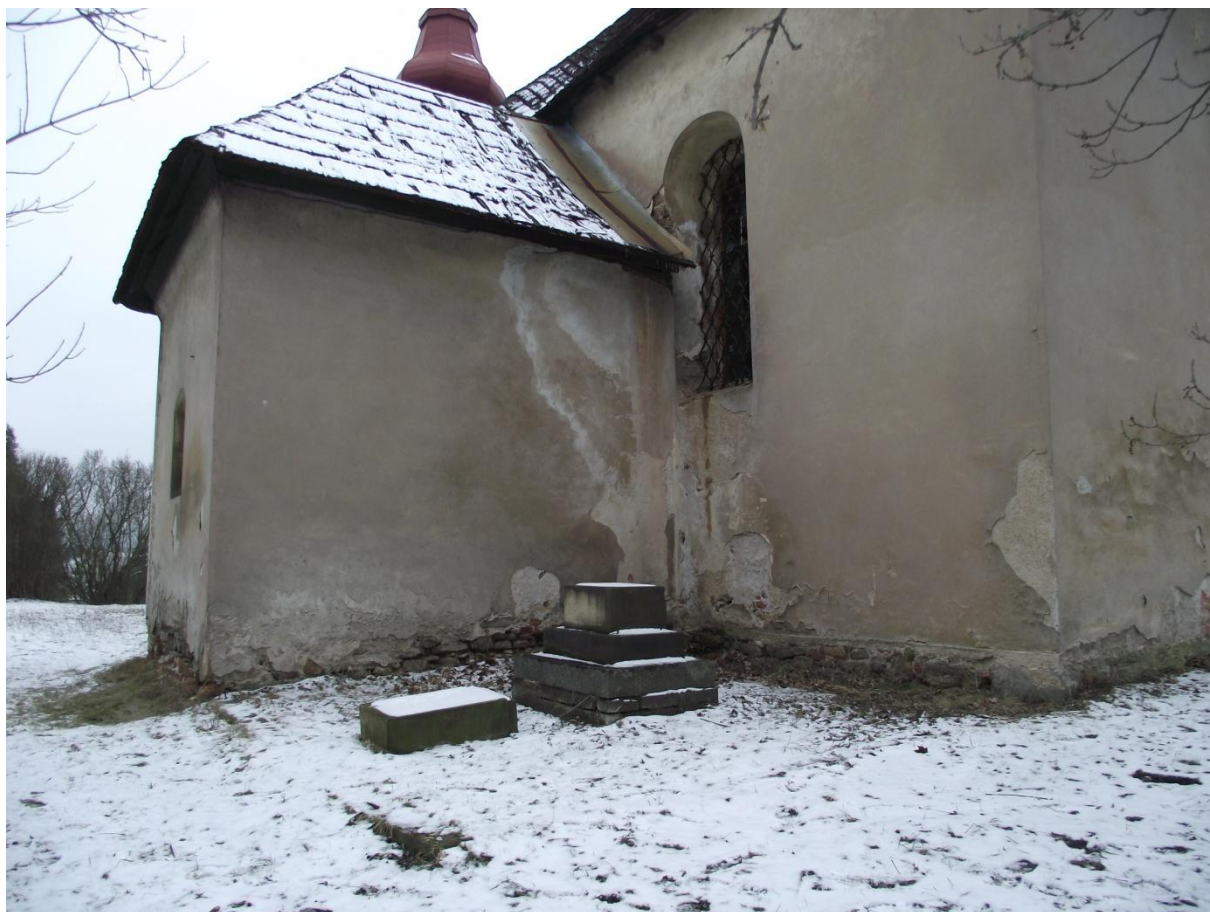
11/ Kostel sv. Mikuláše v Mikulovicích, východní strana saristie a okno presbytáře
