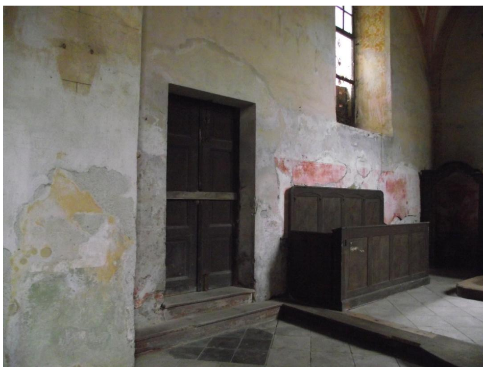
28/ Kostel sv. Mikuláše v Mikulovicích, vstup v severní stěně presbytáře
