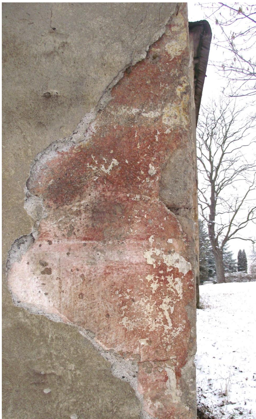
9/ Kostel sv. Mikuláše v Mikulovicích, severní nároží presbytáře
