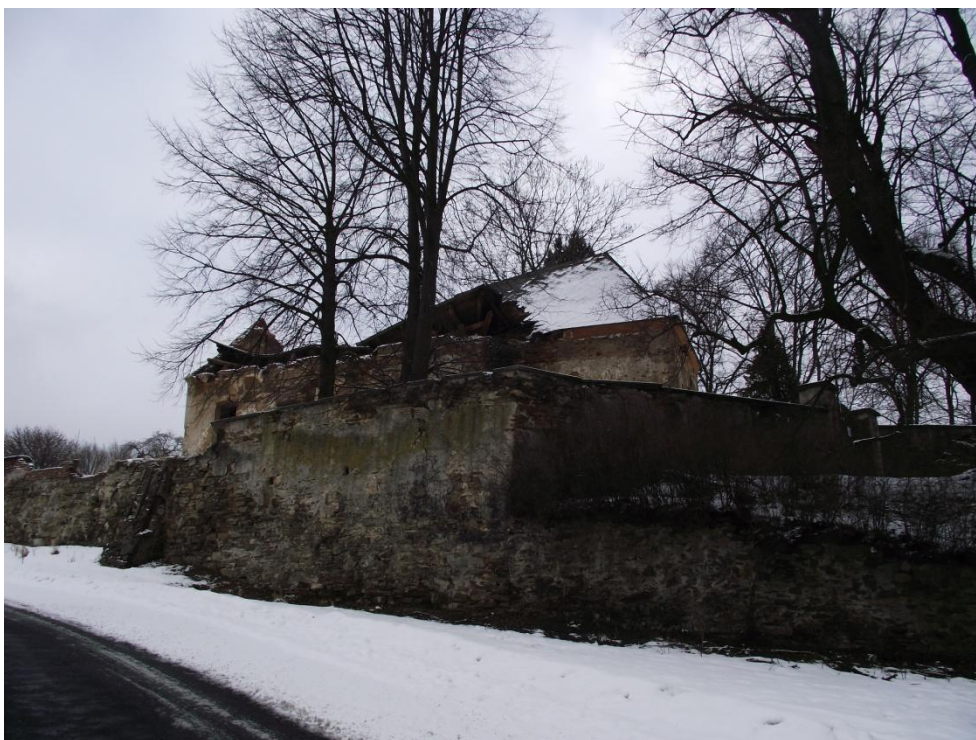
80/ Kostel sv. Jakuba v Loučovicích, pohled od hřbitovní zdi – stav po zřícení střechy lodi
