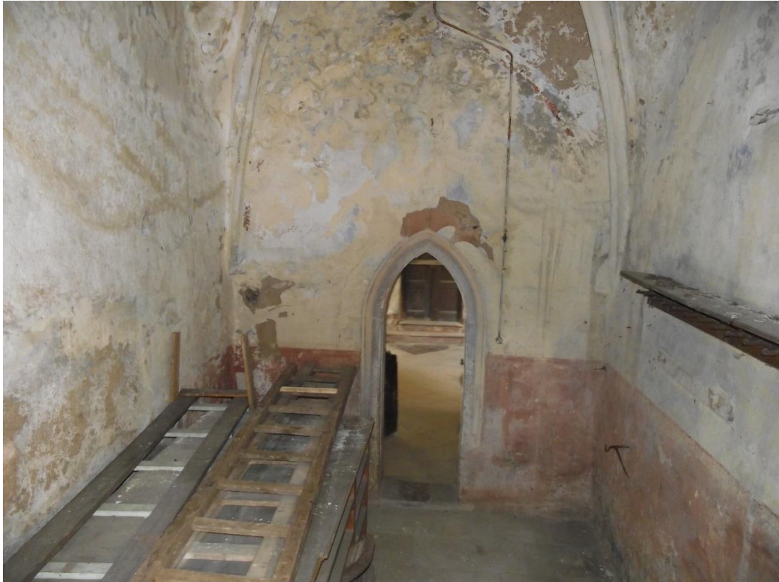
32/ Kostel sv. Mikuláše v Mikulovicích, pohled do sakristie z okna
