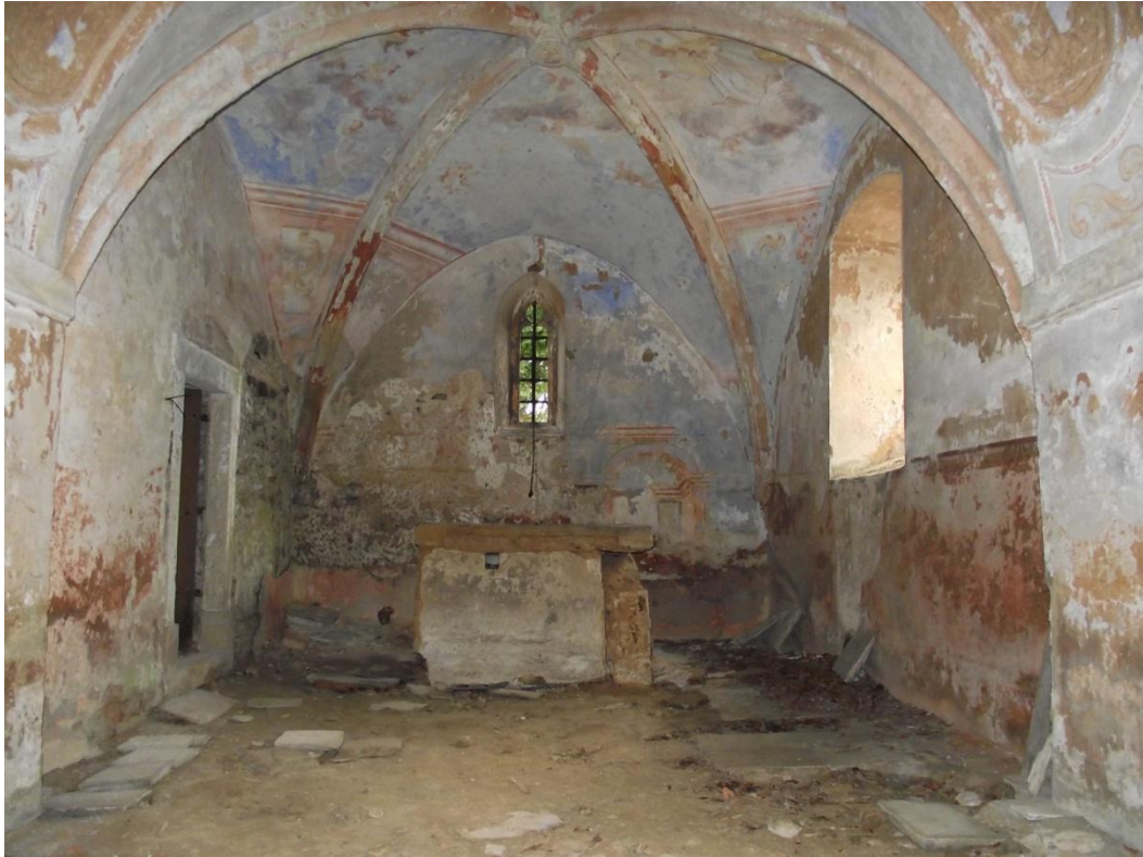
102/ Kostel sv. Petra a Pavla ve Volyni, interiér presbytáře
