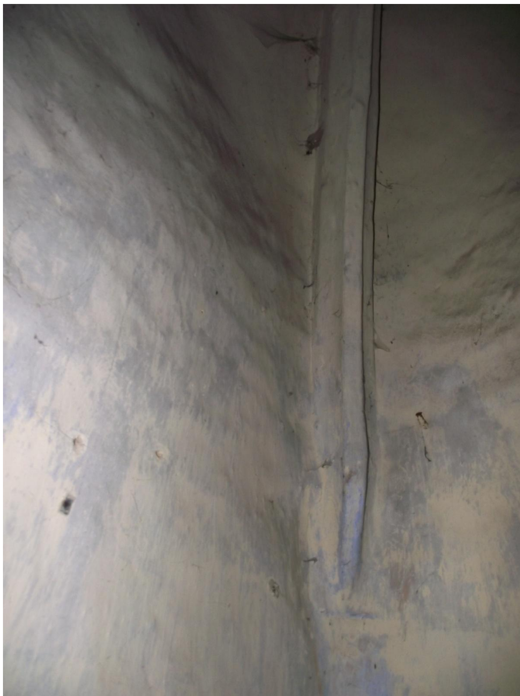
41/ Kostel sv. Mikuláše v Mikulovicích, výběh klenebního žebra sakristie
