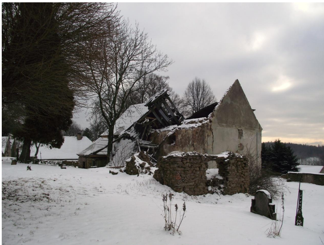
87/ Kostel sv. Jakuba v Loučově, zřícená střecha lodi
