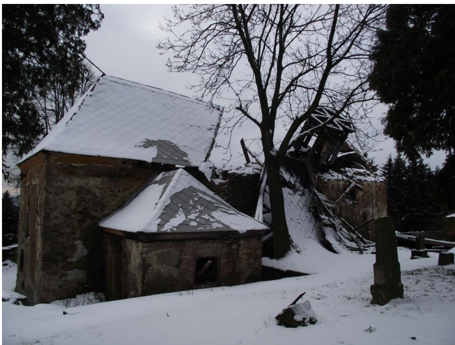
86/ Kostel sv. Jakuba v Louhově, severní strana kostela
