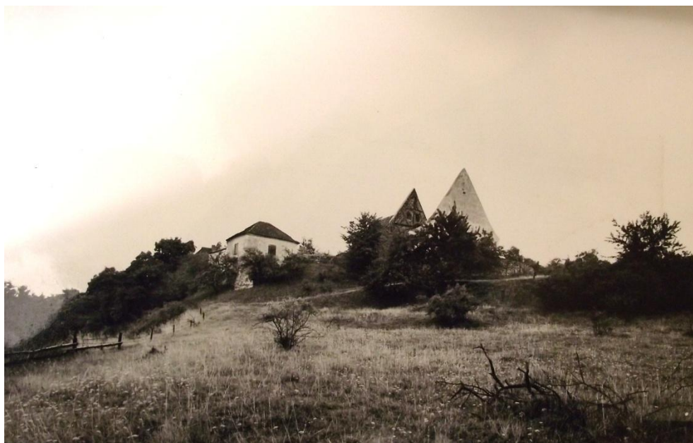
70/ Kostel sv. Vavřince v Želině, stav po vyhoření, Repro: Jan Muk – Otmar Mácha, Želina. Kostel sv. Gottharda (stavebně-historický průzkum), 1978
