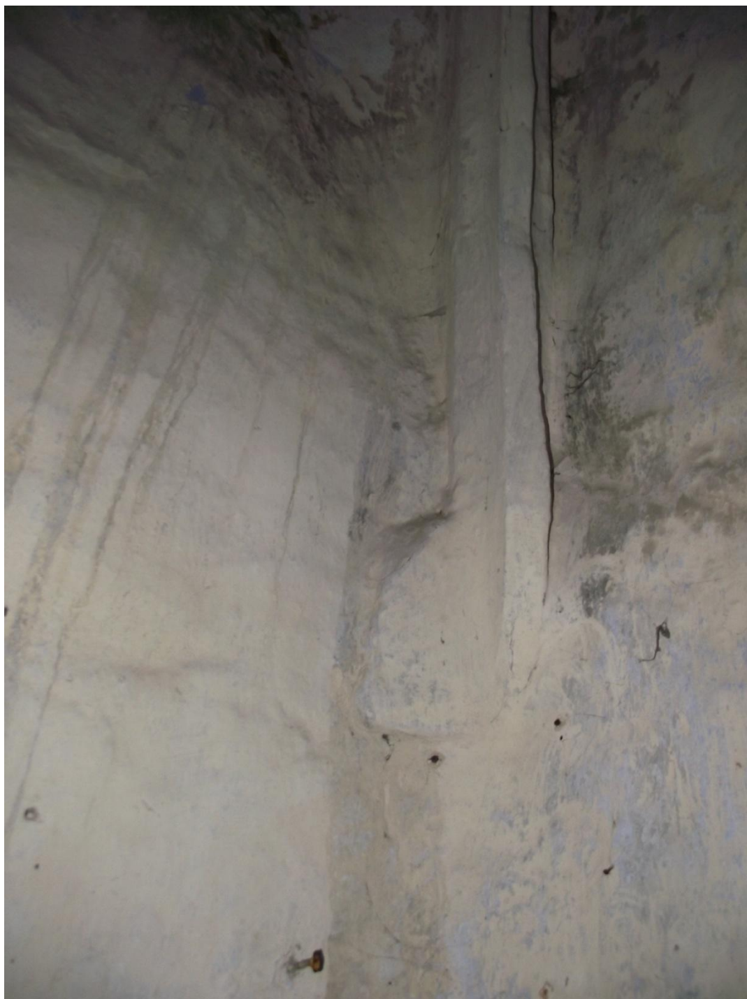
40/ Kostel sv. Mikuláše v Mikulovicích, výběh klenebního žebra sakristie
