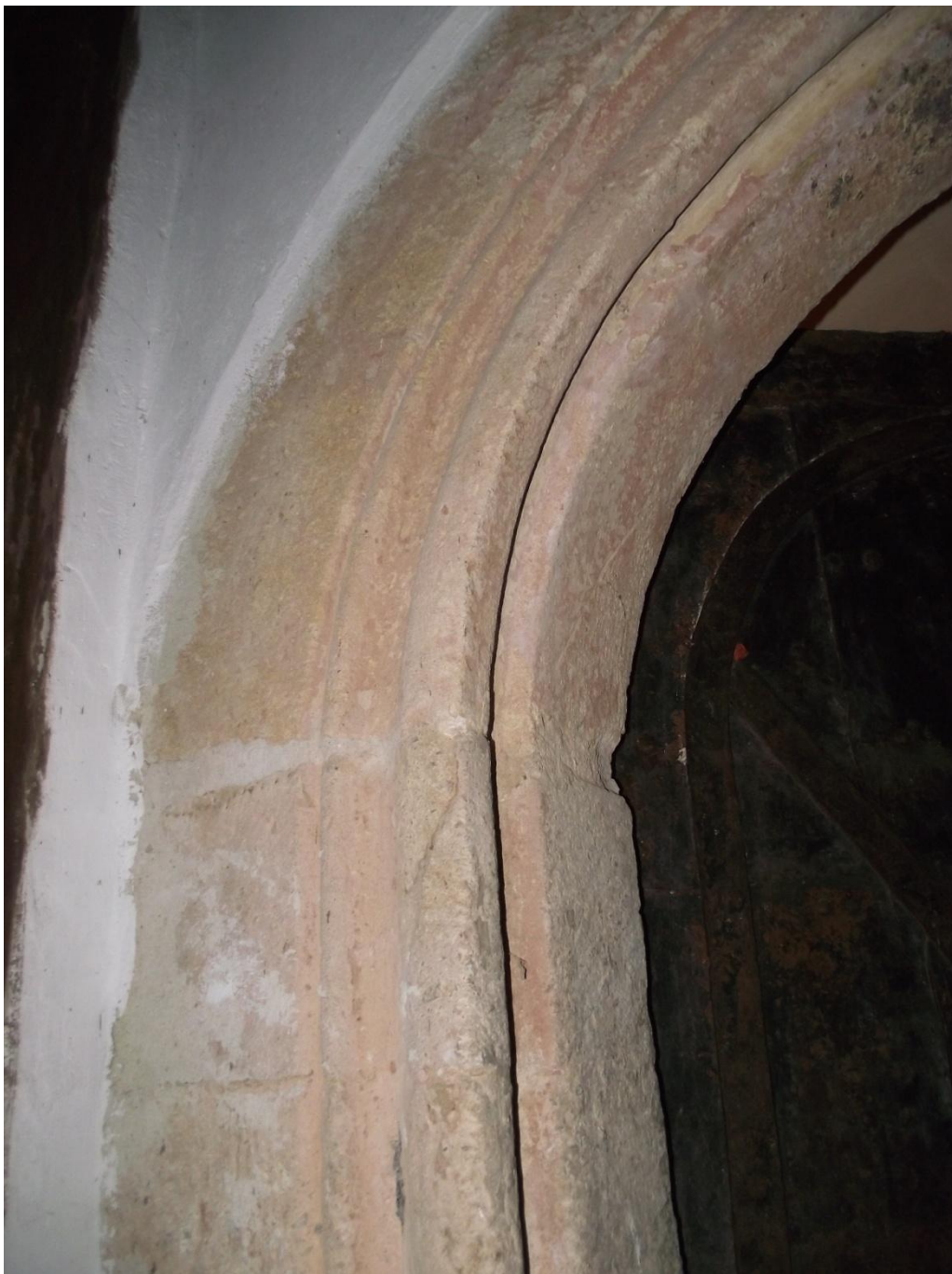
119/ Kostel sv. Havla v Úhošťanech, portál v jižní stěně lodi – detail ostění
