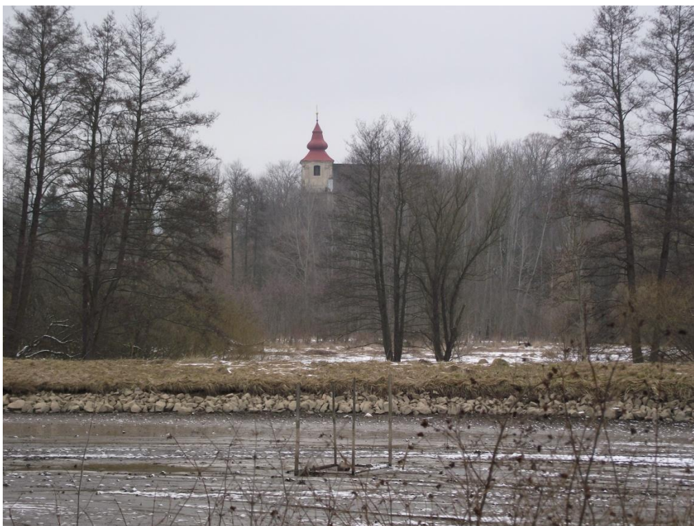
2/ Kostel sv. Mikuláše v Mikulovicích, pohled z údolí od jihu
