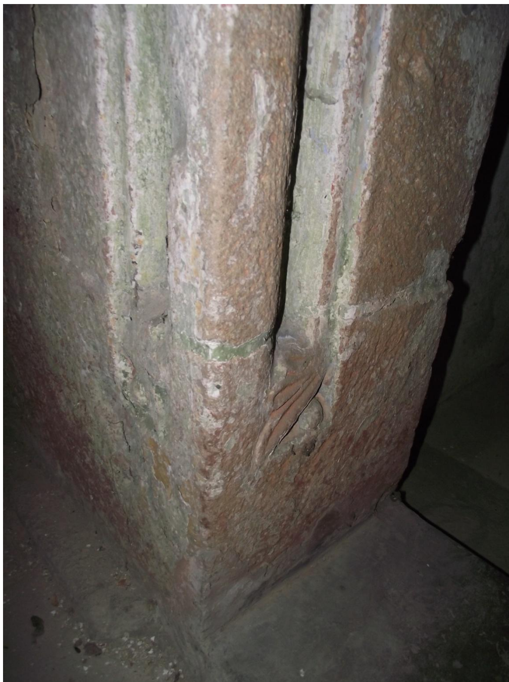
37/ Kostel sv. Mikuláše v Mikulovicích, levá strana ostění portálu v jižní stěně presbytáře – detail trojlistého dekoru
