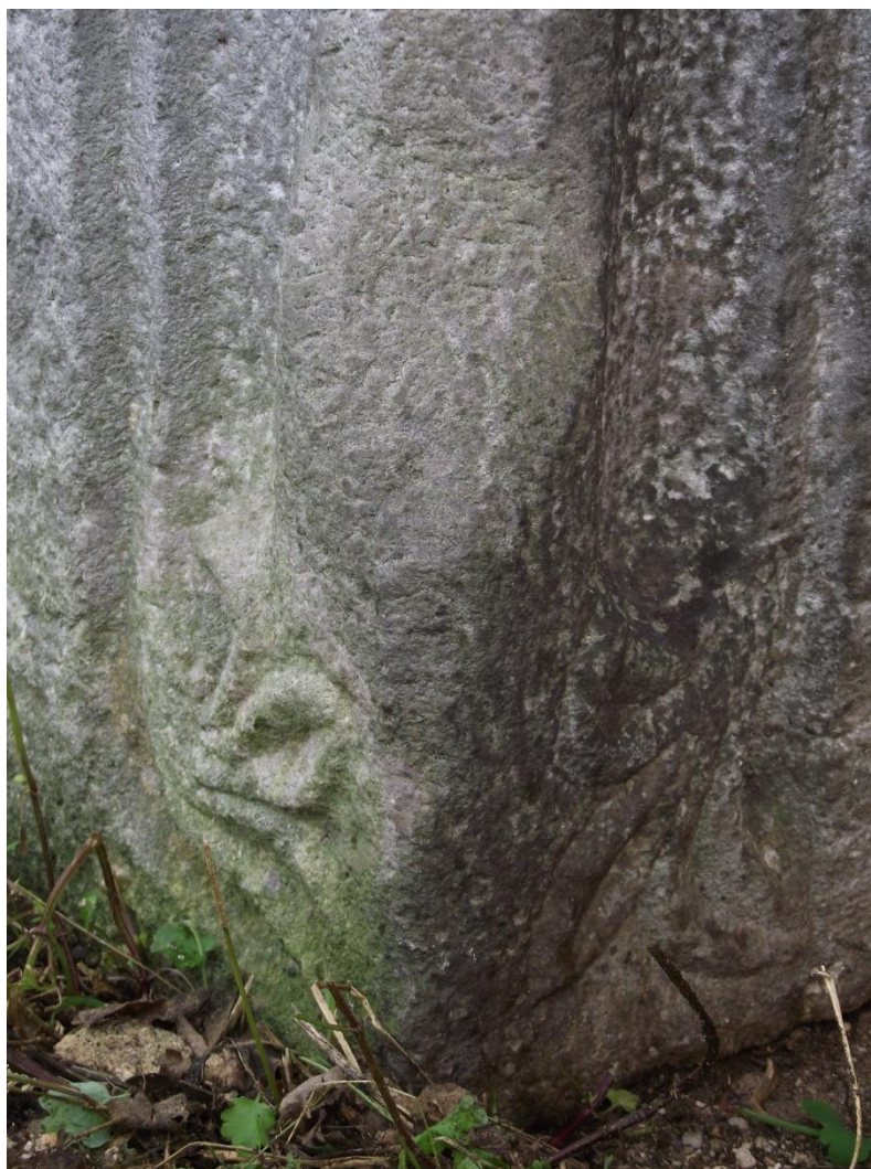
67/ Kostel sv. Vavřince v Želině, portál v západním průčelí, detail trojlistého dekoru
