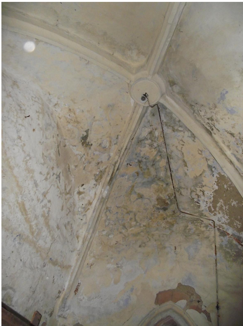
39/ Kostel sv. Mikuláše v Mikulovicích, klenba sakristie
