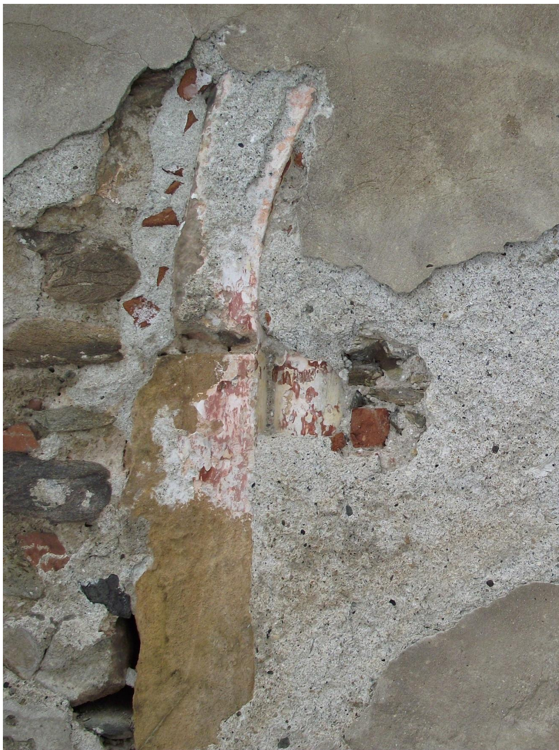
17/ Kostel sv. Mikuláše v Mikulovicích, zazděný jižní portál, detail ostění
