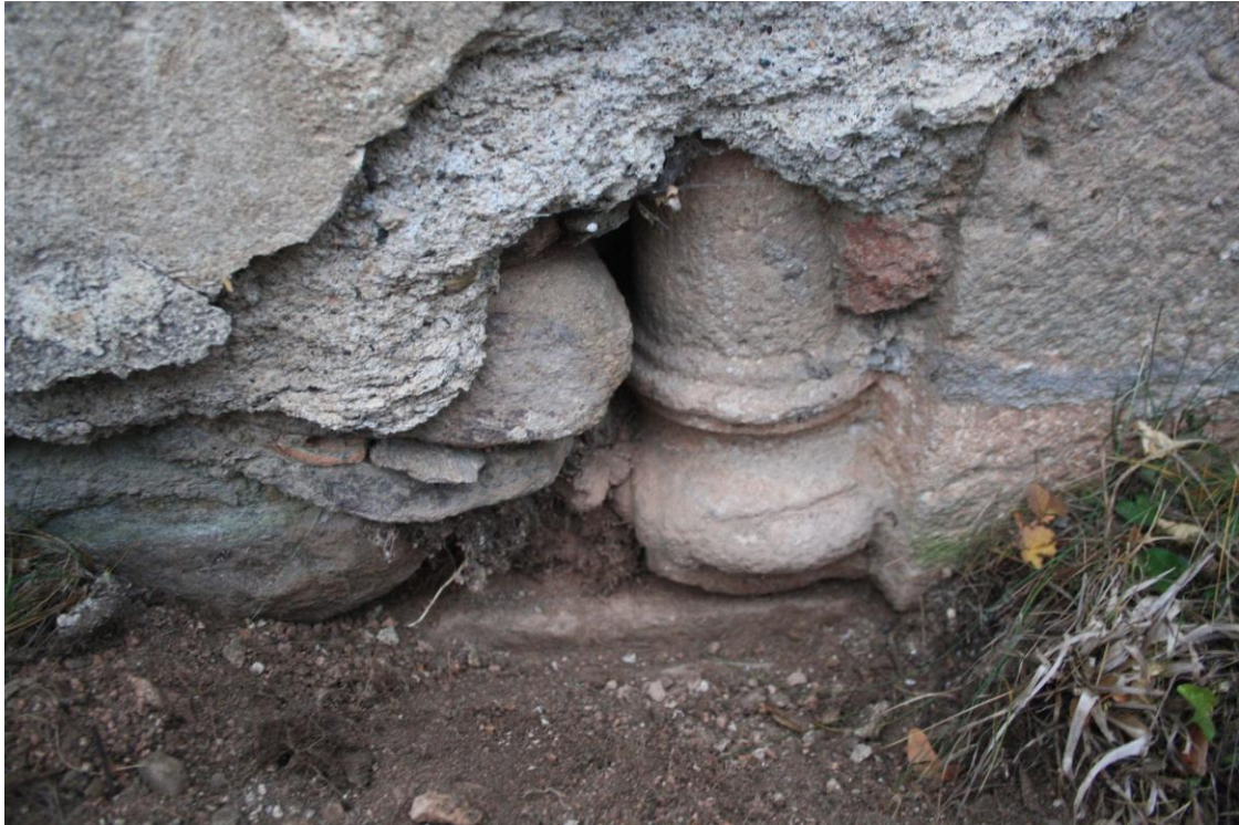
20/ Kostel sv. Mikuláše v Mikulovicích, zadržný jižní portál, práh, Foto: Jiří Crkal
