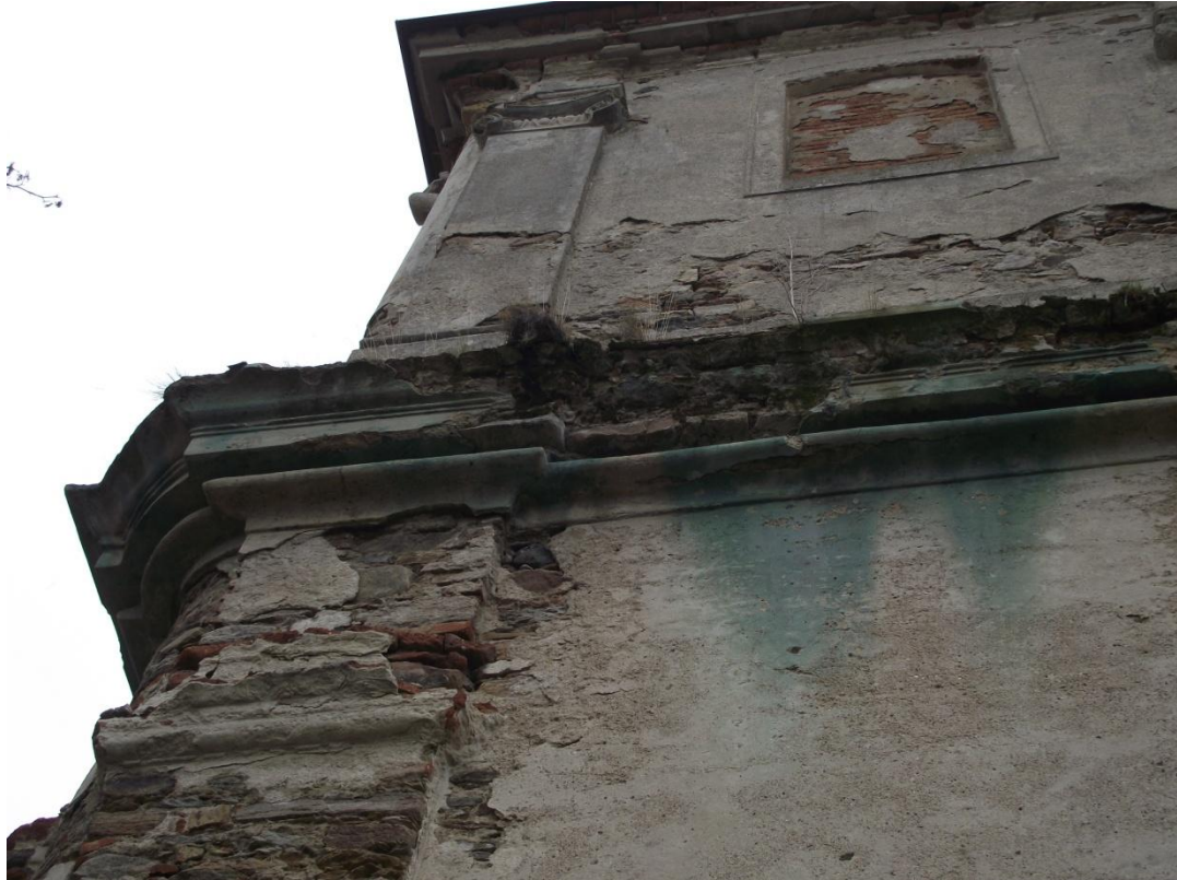
24/ Kostel sv. Mikuláše v Mikulovicích, detail patrové římsy věže
