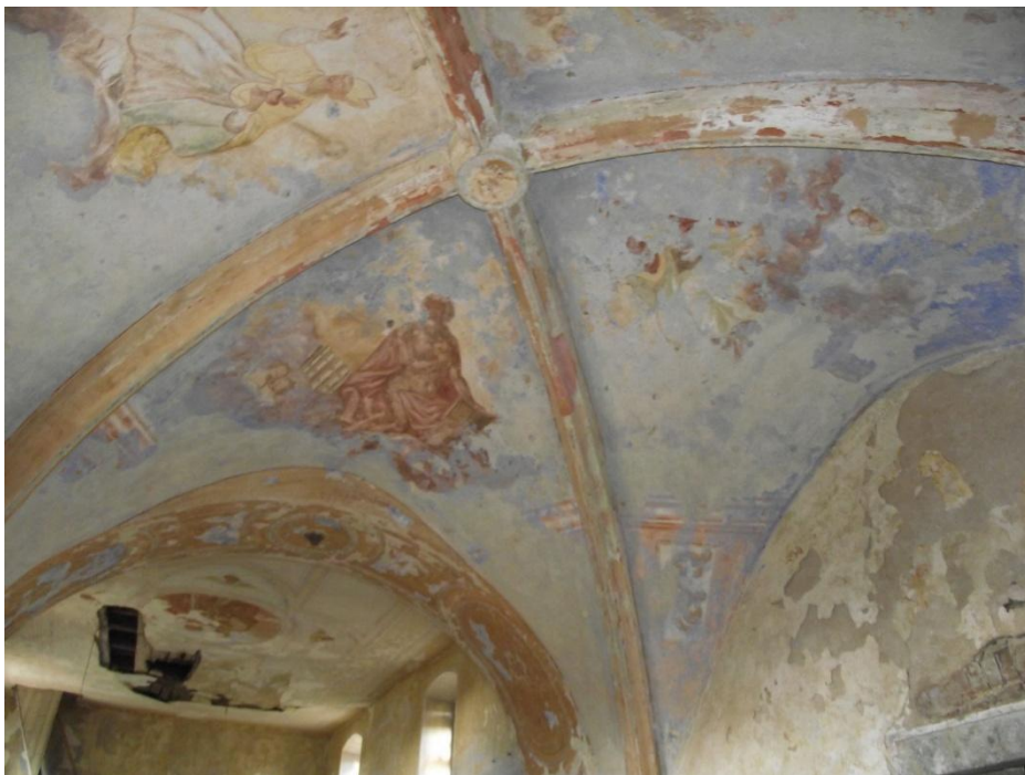
103/ Kostel sv. Petra a Pavla, klenba presbytáře
