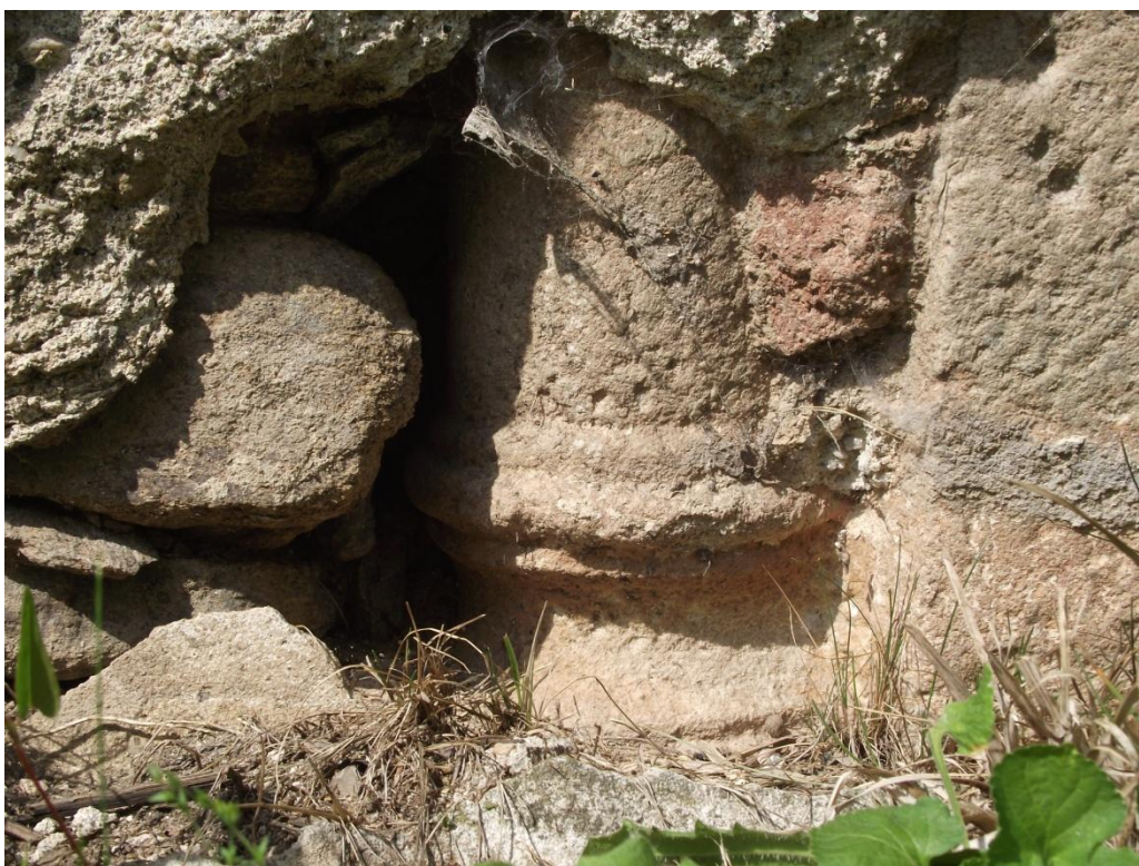
19/ Kostel sv. Mikuláše v Mikulovicích, zazděný jižní portál, pravá patka
