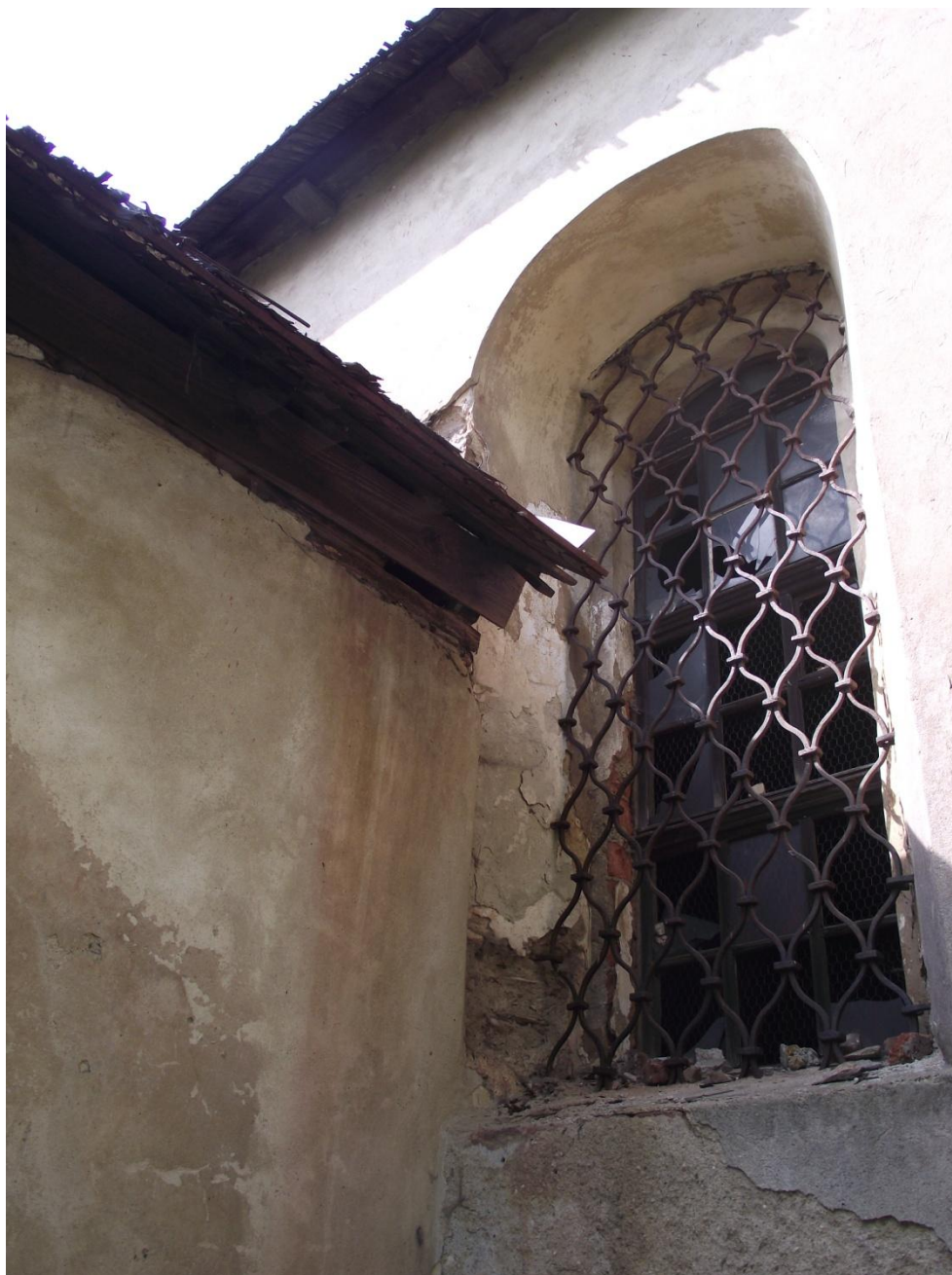
12/ Kostel sv. Mikuláše v Mikulovicích, okno presbytáře a sakristie
