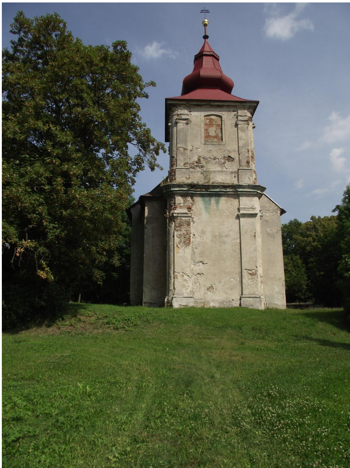
22/ Kostel sv. Mikuláše v Mikulovicích, západní průčelí věže
