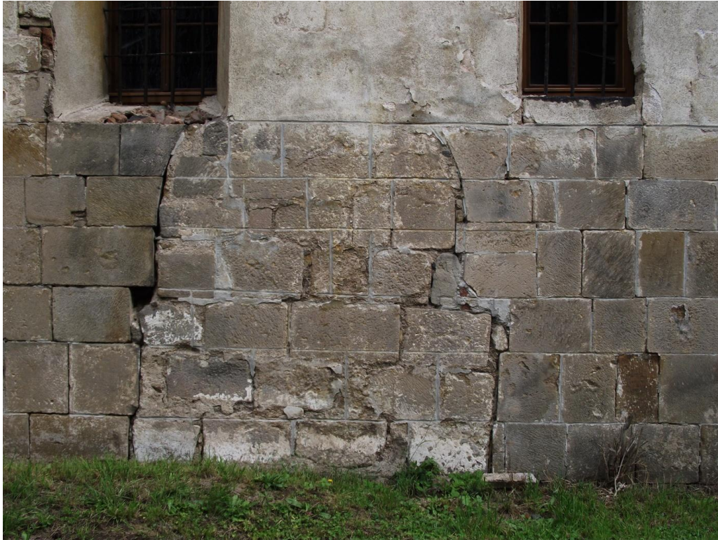
56/ Kostel sv. Vavřince v Želině, jižní strana nynějšího presbytáře, druhotně zazděné místo jižního portálu
