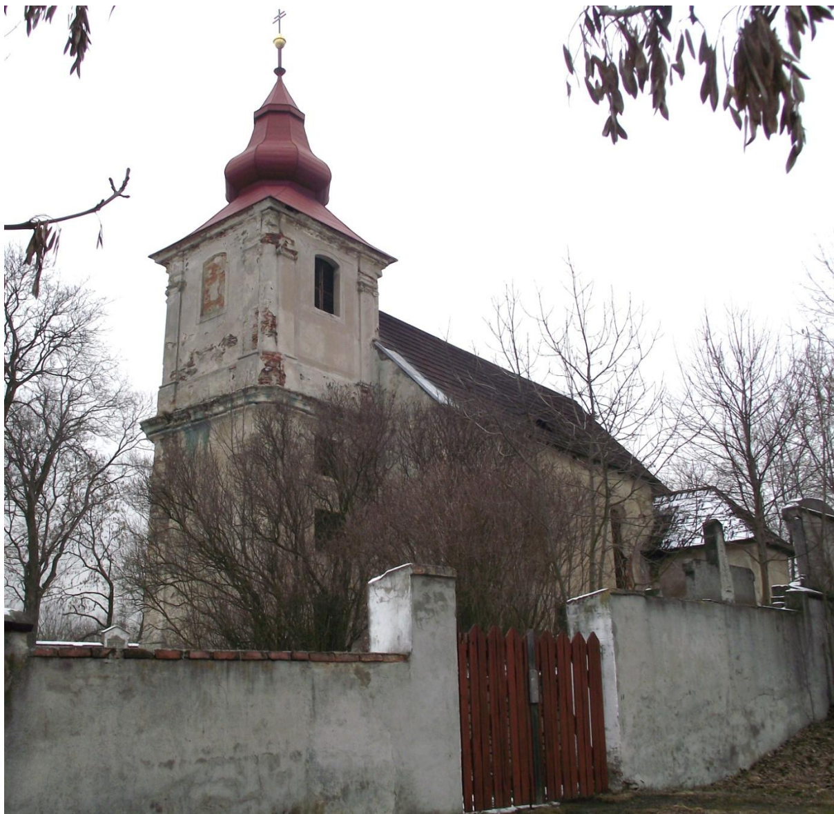
8/ Kostel sv. Mikuláše v Mikulovicích, pohled od hřbitovní zdi
