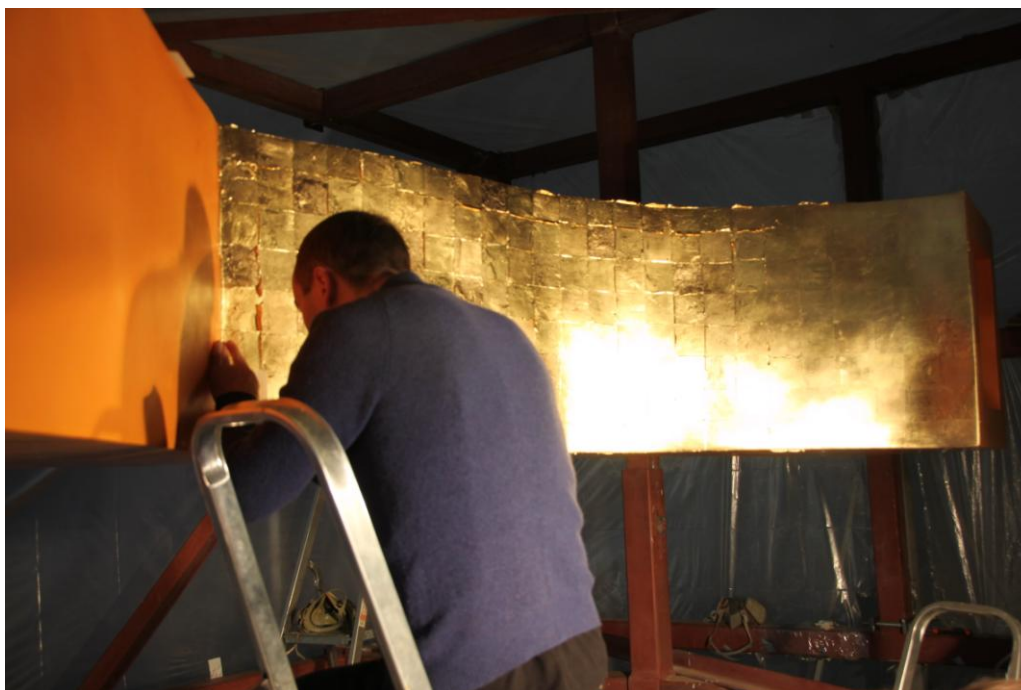
Obrázek č. 26: průběh zlacení kašny Chrtice
