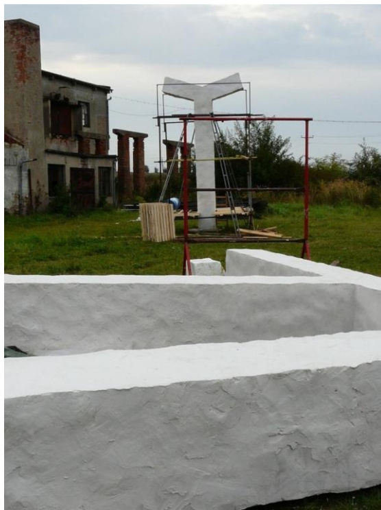
Obrázek č. 22: realizace kašny Anděl, sádrování
