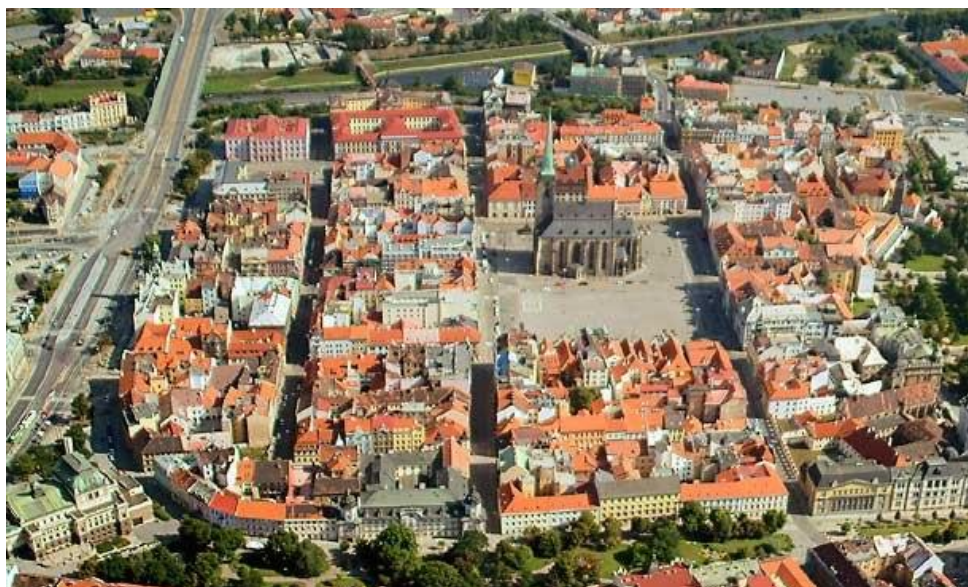
Obrázek č. 5: pohled na náměstí z jihu, letecký snímek
