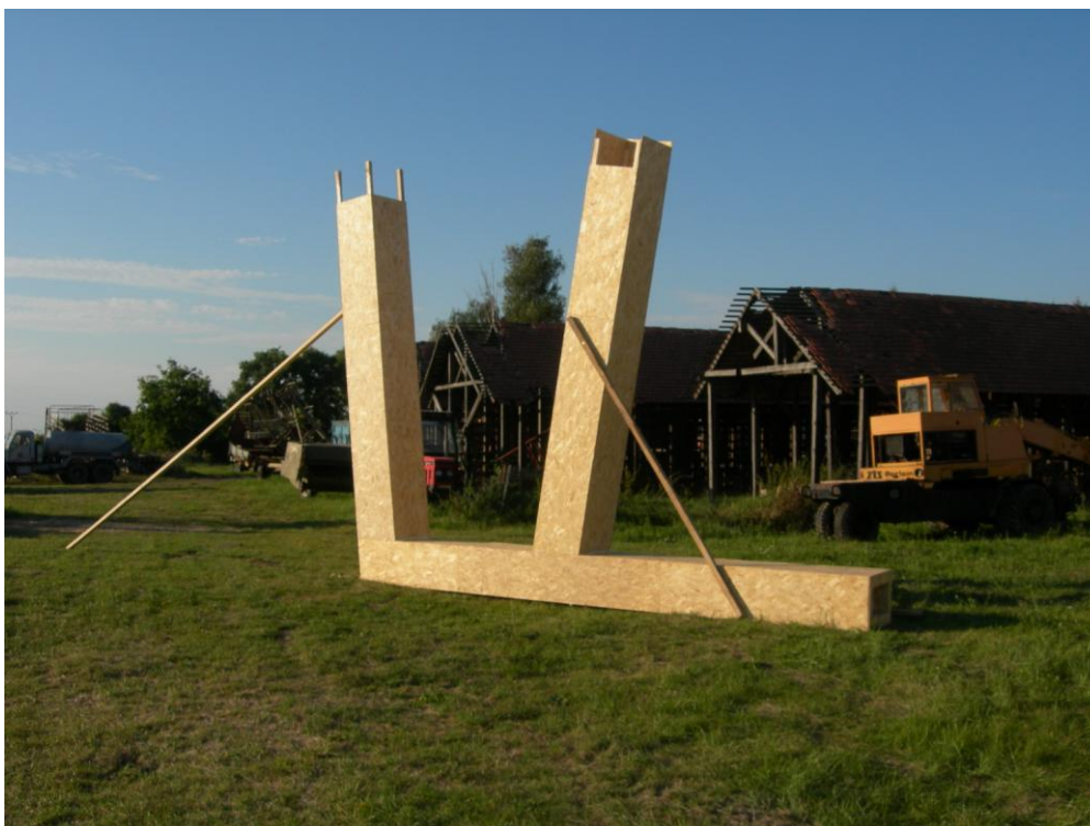
Obrázek č. 21: realizace kašny Velbloud, dřevěná forma
