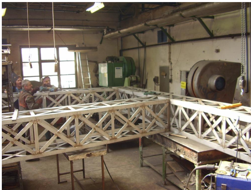
Obrázek č. 23: konstrukce kašny Velbloud
