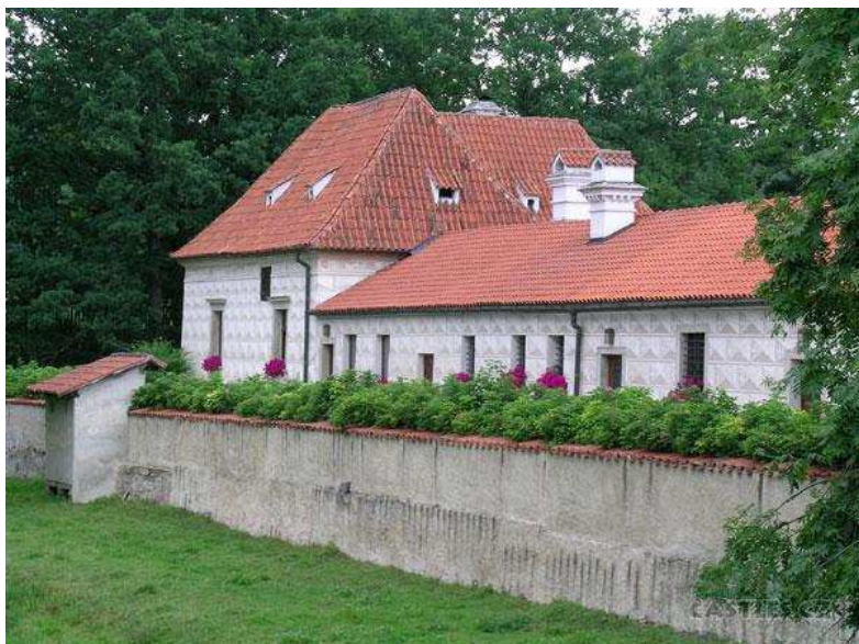
Obr.22- Bašta v JZ nároží areálu
