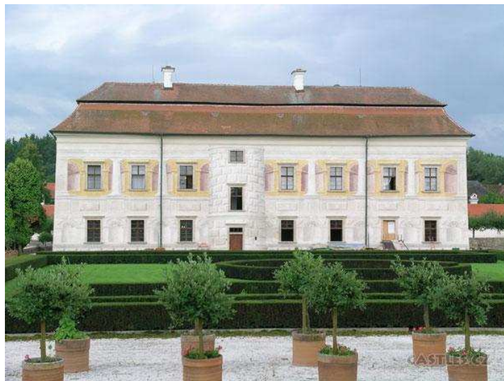
Obr.16 – Severní průčelí „vily“
