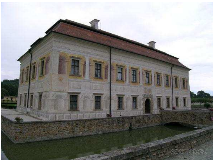
Obr.17 - „Vila“ pohled od JZ
