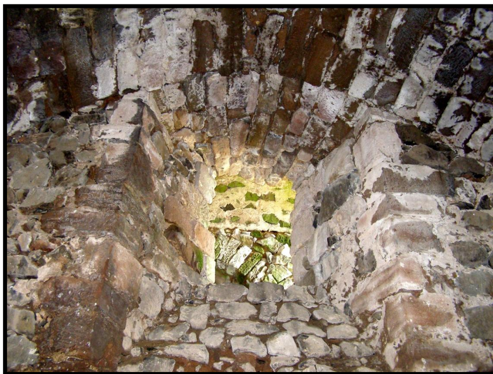
Foto 2. Kumburk – Okno v JV čelní zdi suterénu (foto autor).
