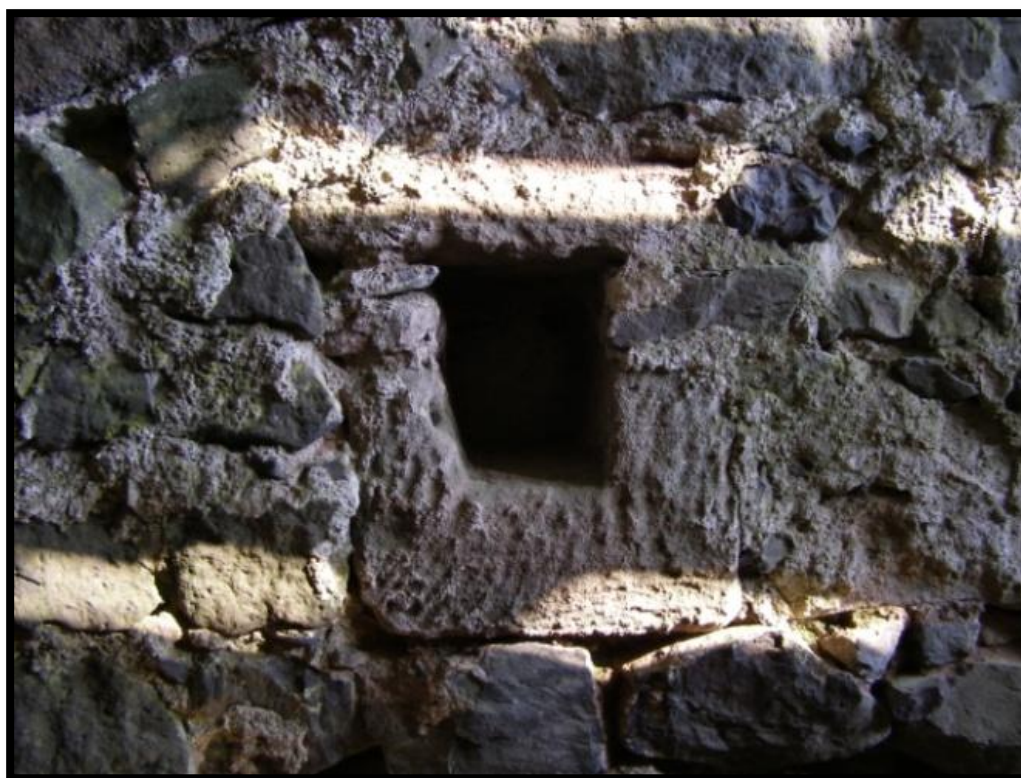
Foto 6. Kumburk - Výklenek v jižní stěně schodiště do suterénu paláce (foto autor).
