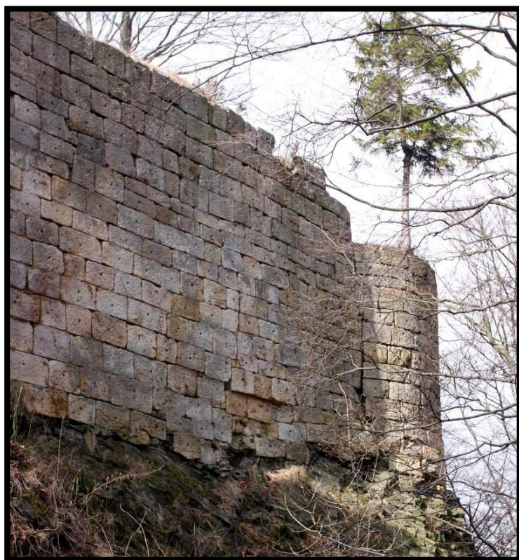
Foto 13. Bradlec - Detail zdiva paláce s půlkruhovou věží, pohled od východu (foto autor).
