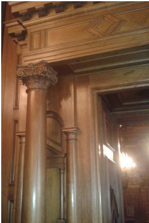
Obr. 23. Hluboká, Velká jídelna, detail portálu – korintský sloup
