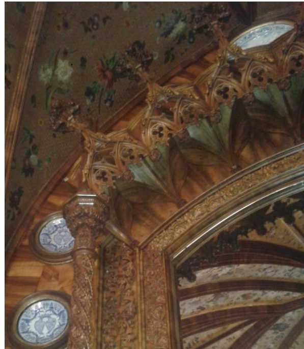
Obr. 15. Hluboká, Čítárna, detail horního rámu zrcadla
