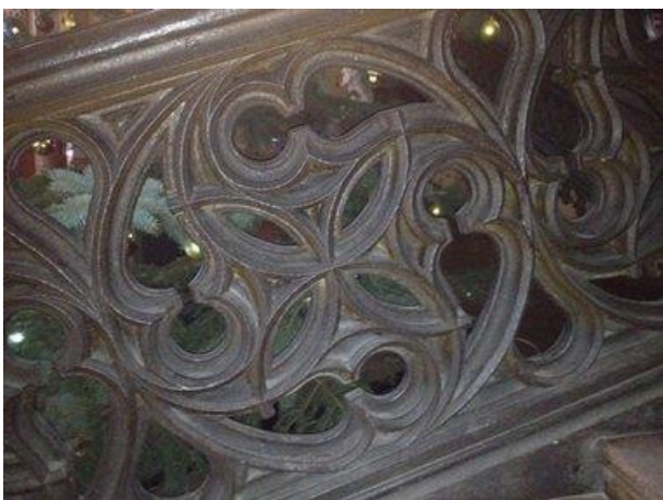
Obr. 31. Sychrov, Schodišťová hala, detail zábradlí
