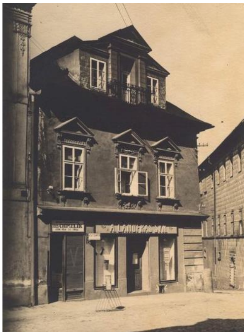
Obr. 16. Průčelí do Komenského ulice. Podoba průčelí pravděpodobně před rekonstrukcí v roce 1965.
