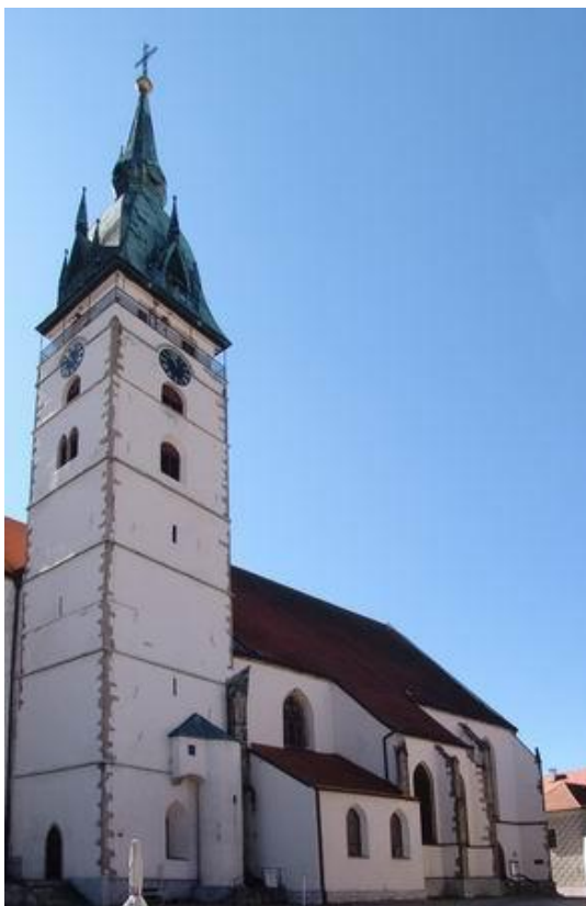
Obr. 3. Kostel Nanebevzetí Panny Marie v Jindřichově Hradci
