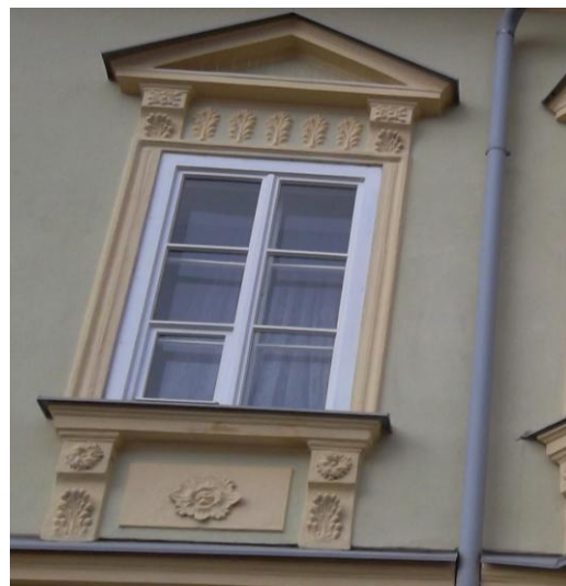
Obr. 7b. Okno prvního patra domu č. p. 69 na Masarykově náměstí.
