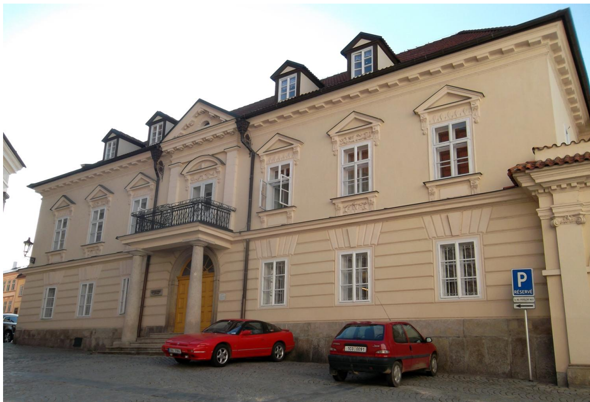
Obr. 10. Průčelí Landfrasovy tiskárny směrem na Balbínovo náměstí.
