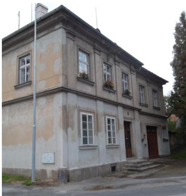
Obr. 20. Severozápadní průčelí Landfrasovy vily s hlavním vchodem.
