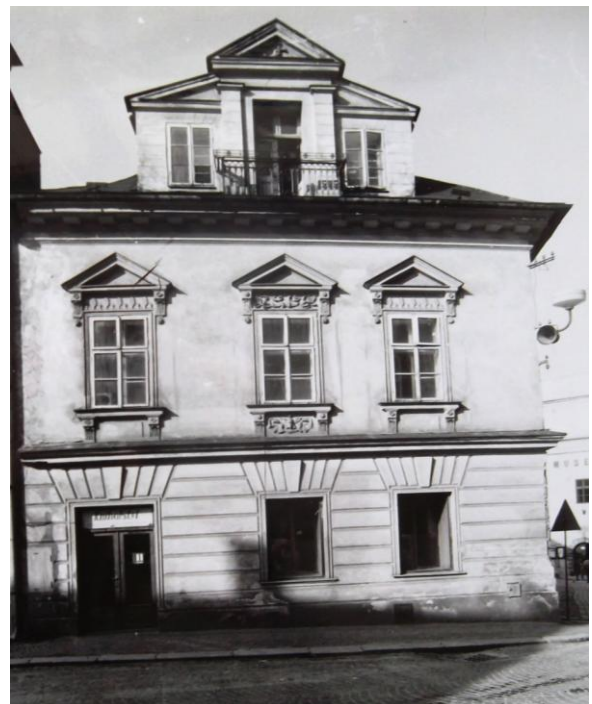
Obr. 17. Průčelí do Komenského ulice. Stav v roce 1987.
