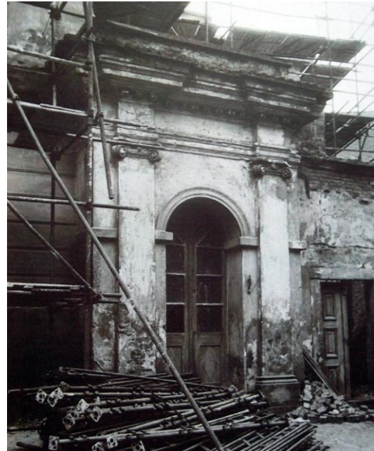
Obr.18b. Kaplička sv. Aloise. Stav před rekonstrukcí v letech 1994- 1995.
