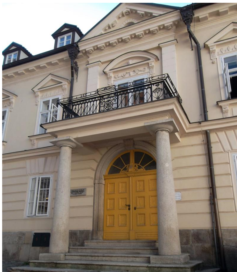
Obr. 13. Portikus a vchod na balkonek umístěný v edikule.
