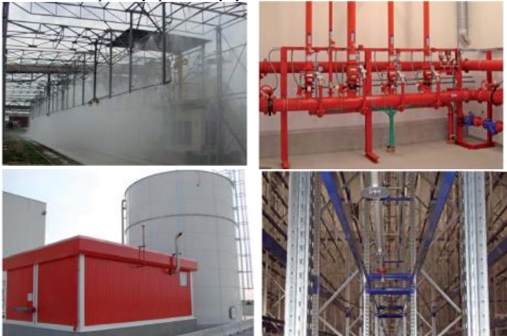
Obrázek 1: Protipožiarny sprinklerový systém
