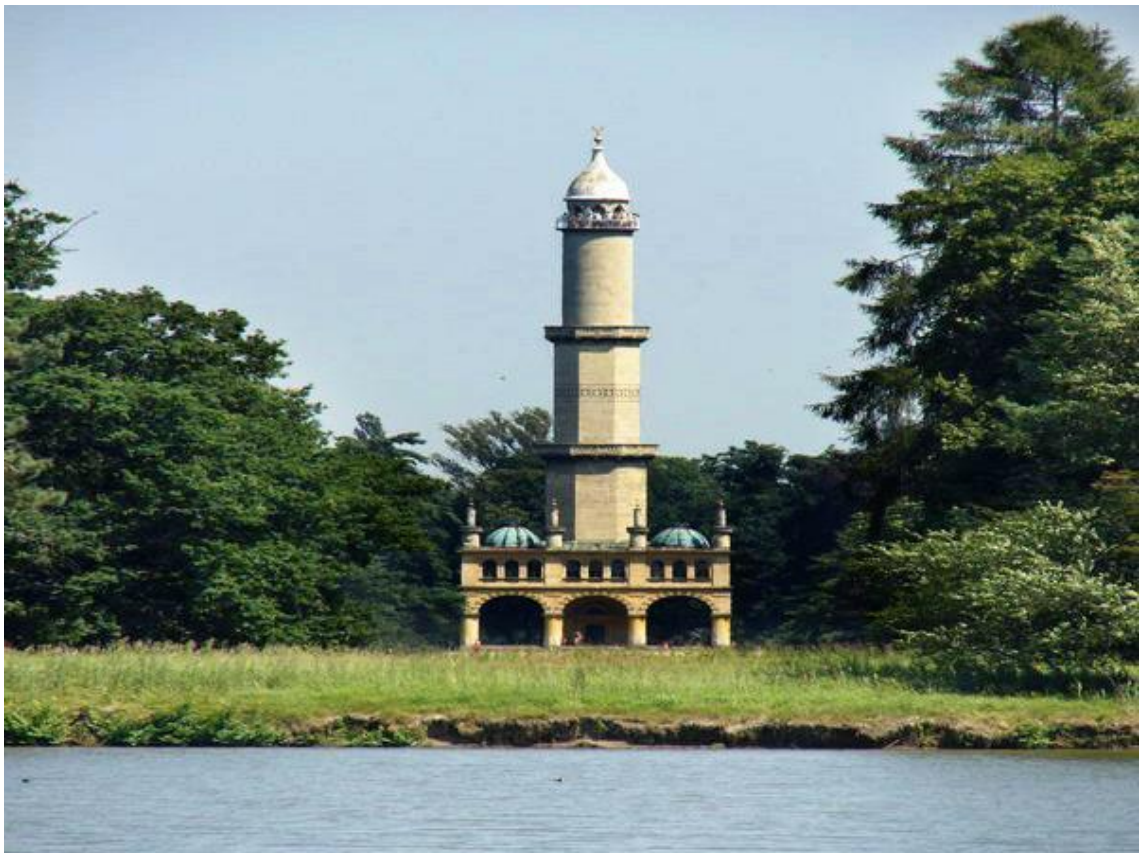
(Obr. 43.) Minaret v Lednici
