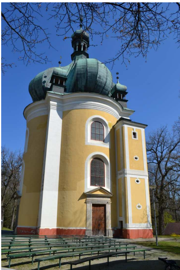
[3] Celkový pohled na kostel s dostavěnou schodišťovou věží.
