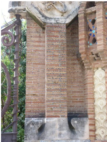
Obr. 205 a 206: detaily spár ve sloupu
