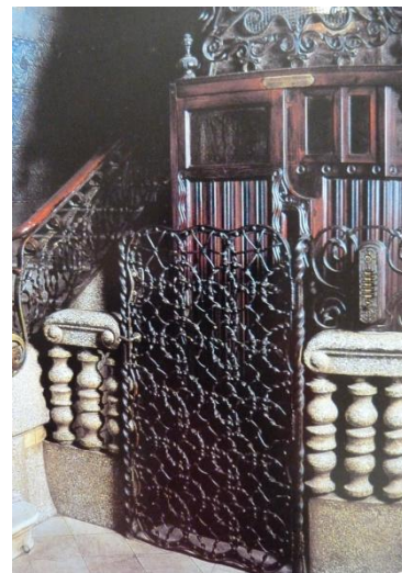
Obr. 325: detail mříže a balustrády
