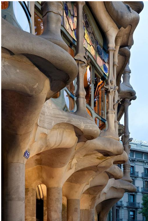
Obr. 434: zvlňný tvar hlavní fasády
