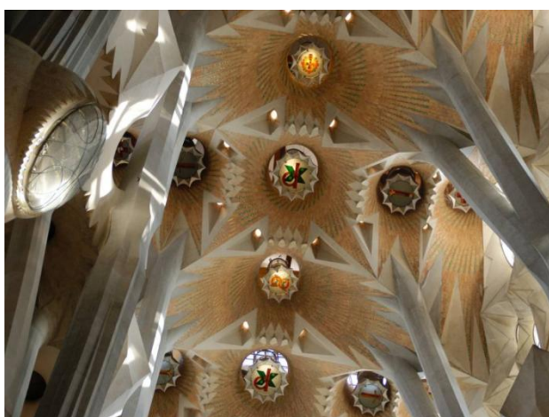
Obr. 126: detail interiérové klenby
