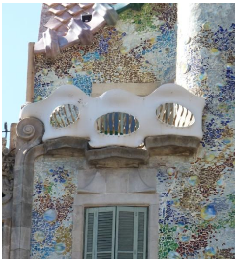
Obr. 444: detail balkonu ve 4. patře
