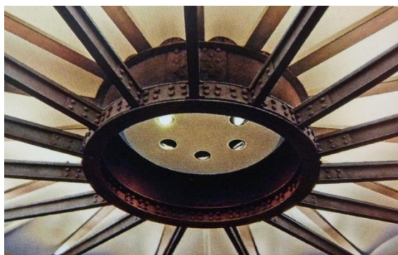
Obr. 499: kovová konstrukce v suterénu
