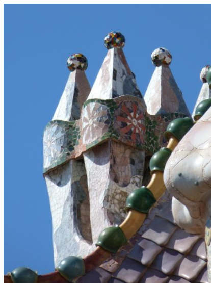
Obr. 478: detail techniky trencadís
