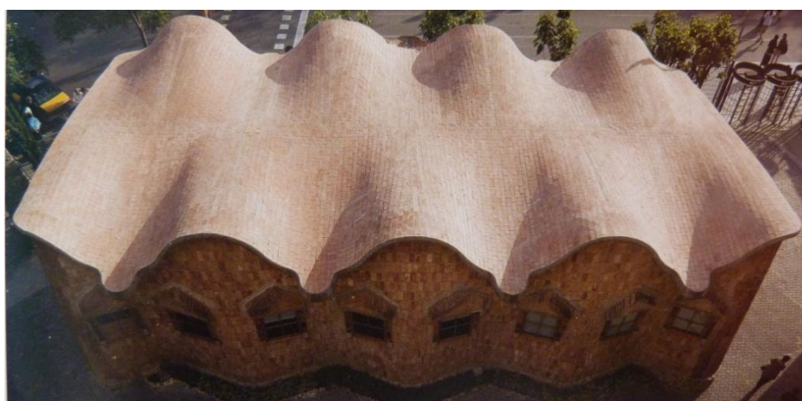
Obr. 132: vlnitá střecha budovy
