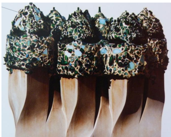
Obr. 528: komíny pokryté střepy z lahví
