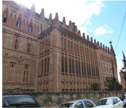
Obr. 263: zadní vchod do budovy
