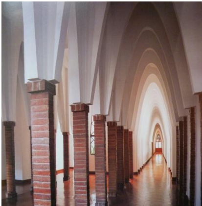
Obr. 264 a 265: parabolické oblouky v interiéru budovy
