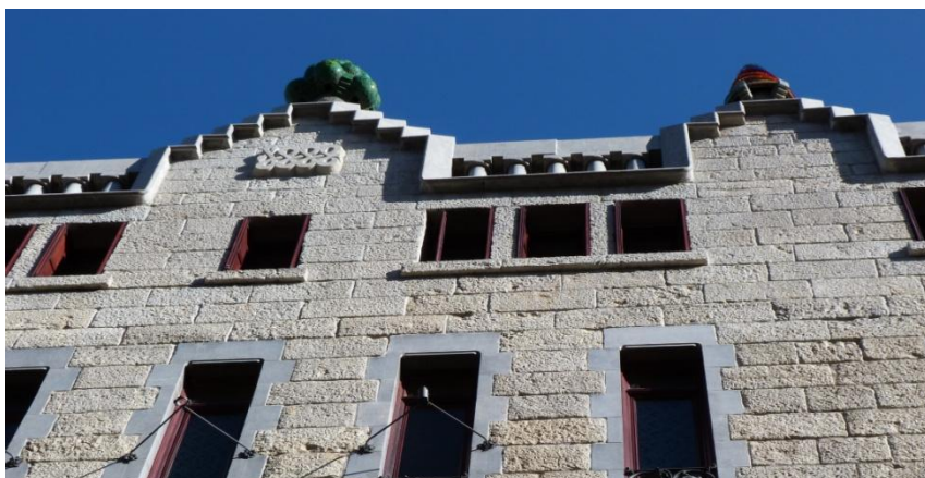
Obr. 226: vrchol hlavní fasády
