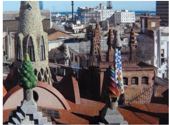
Obr. 259: cihlová nástavba na střeše
