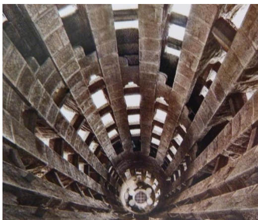
Obr. 110: dutá část zvonice
