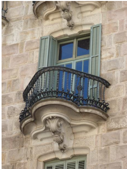
Obr. 294 a 295: balkon s půdorysem trojlistu a zdobnou konzolou
