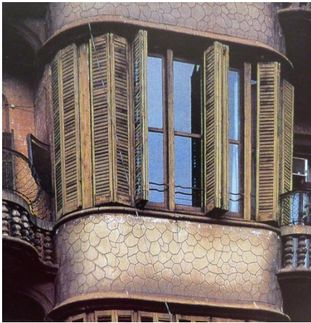
Obr. 313: detail zasklených arkýřů
