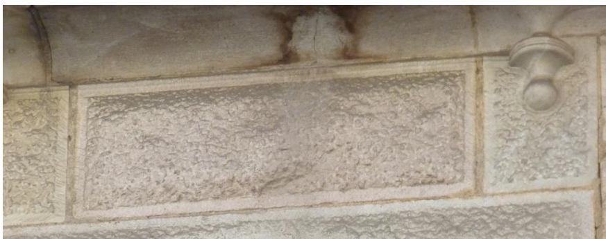
Obr. 312: rustikálně opracovaný pískovec
