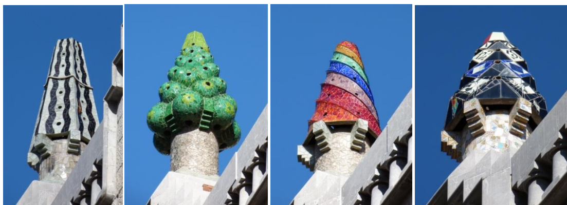
Obr. 257: obložení komínů a větracích šachet
