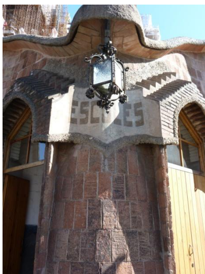
Obr. 131: vchod do budovy
