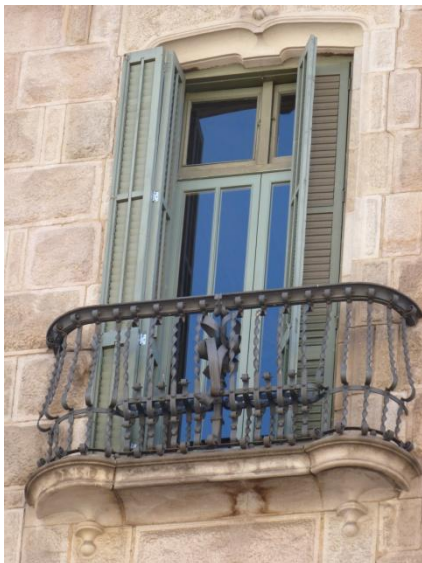
Obr. 296: nepatrně vyčnívající balkon
