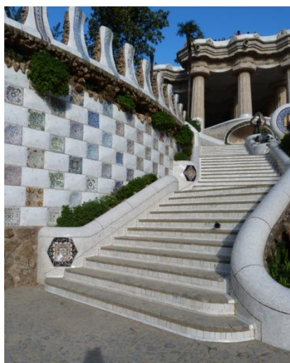
Obr. 397: exteriérové schodiště v parku
