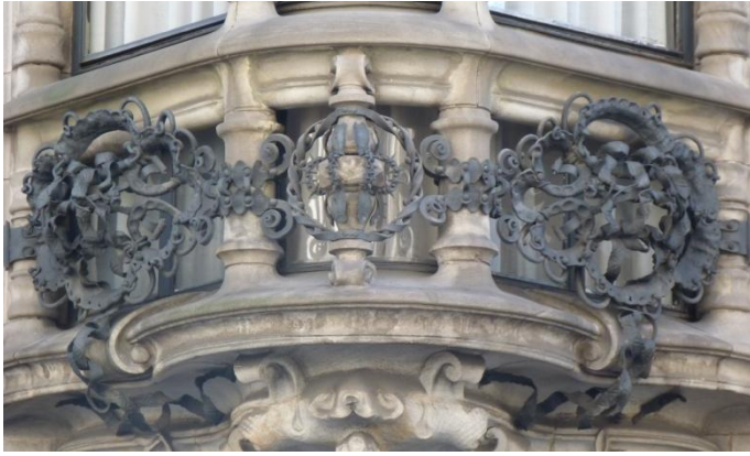
Obr. 301: kovová konstrukce v dolní části arkýře
