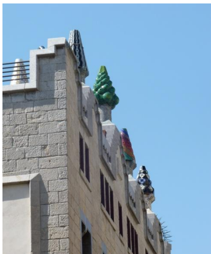
Obr. 217: věžové nástavby na střeše
