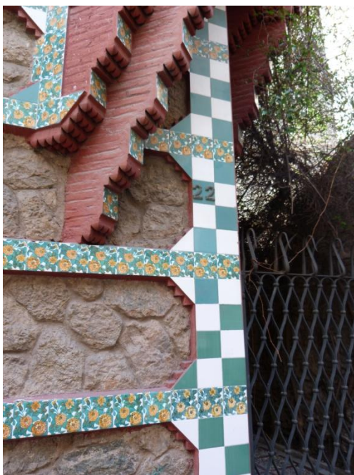
Obr. 153: kámen v kombinaci s cihlami
