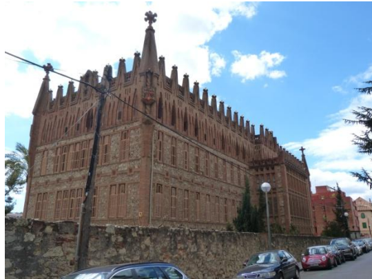
Obr. 270 a 271: fasáda stavby
