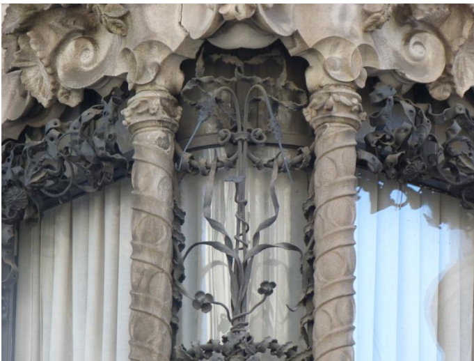
Obr. 302: kovová konstrukce v oknech arkýře
