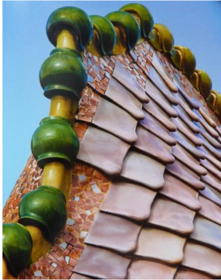
Obr. 447: detail ohrazení střechy
