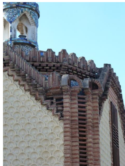
Obr. 189: detail rohu budovy
