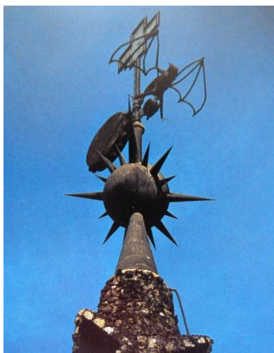
Obr. 256: detail zakončení špičaté věže
