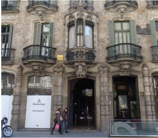
Obr. 292: odlehčení fasády otvory
