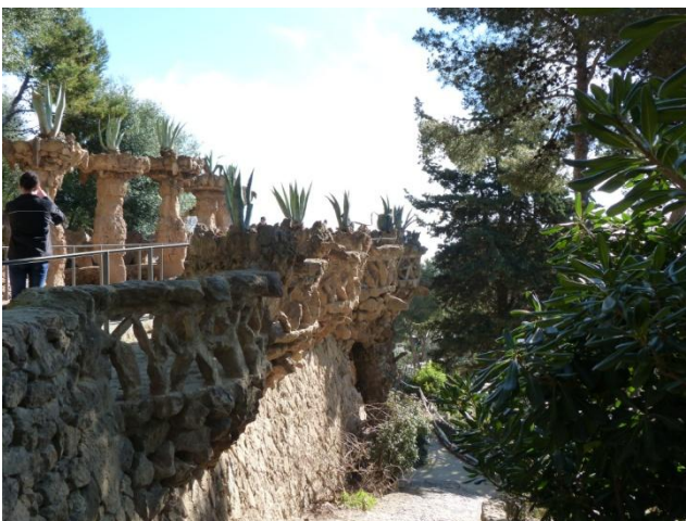
Obr. 427: sloupy a kamenné zábradlí s květináči
