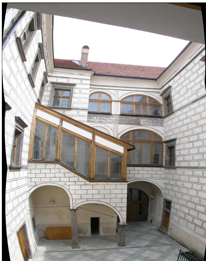
33. Dvorní průčelí Staré radnice v Prachaticích.
