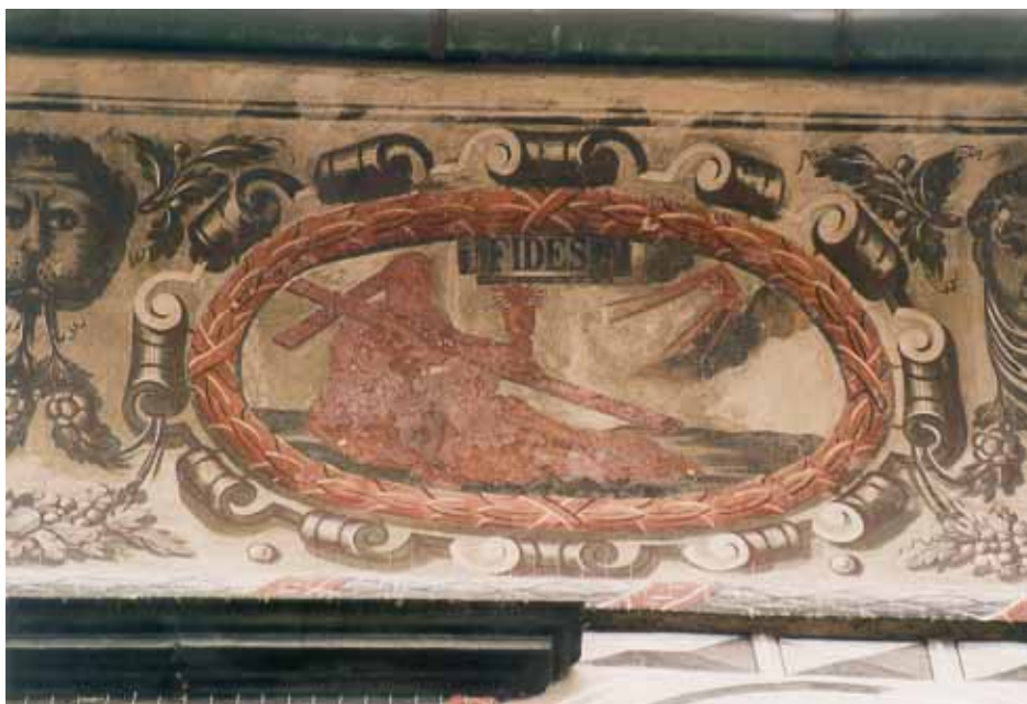
9. Fides, hlavní průčelí – pás pod římsou, Stará radnice.
