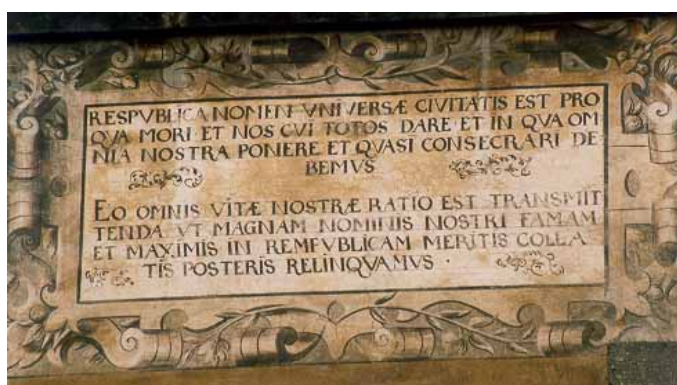
22. První nápis, hlavní průčelí Staré radnice.
