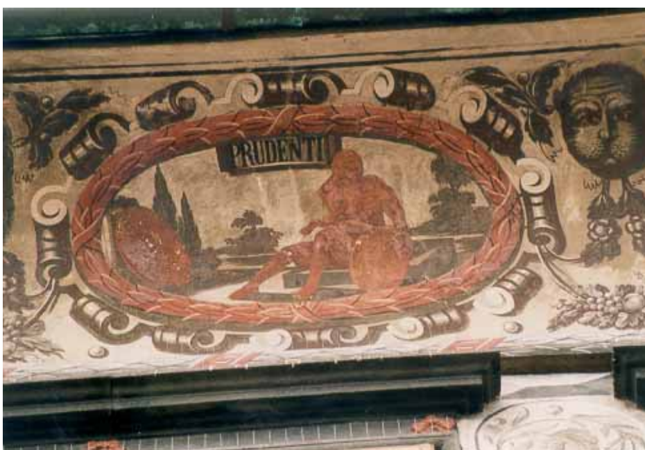
6. Prudentia, hlavní průčelí - pás pod římsou, Stará radnice.
