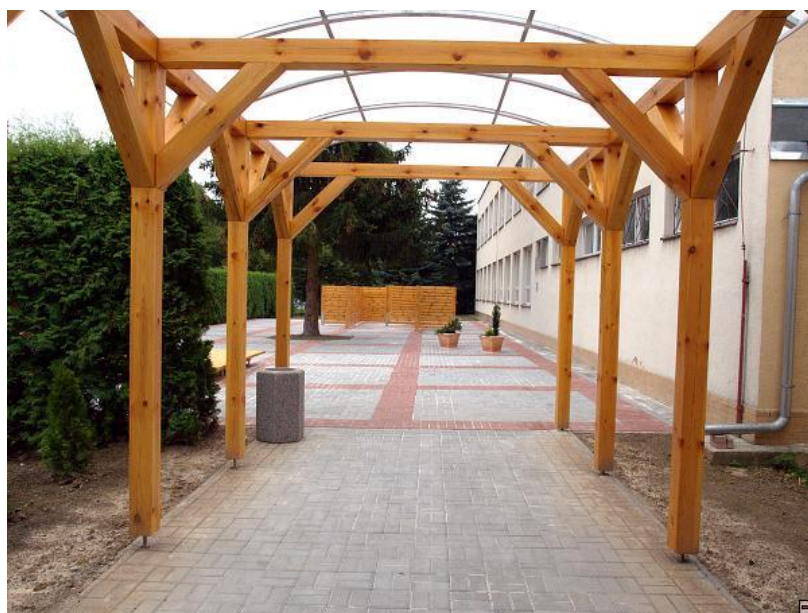
Obr. 5 - Upravený venkovní prostor ZŠ
