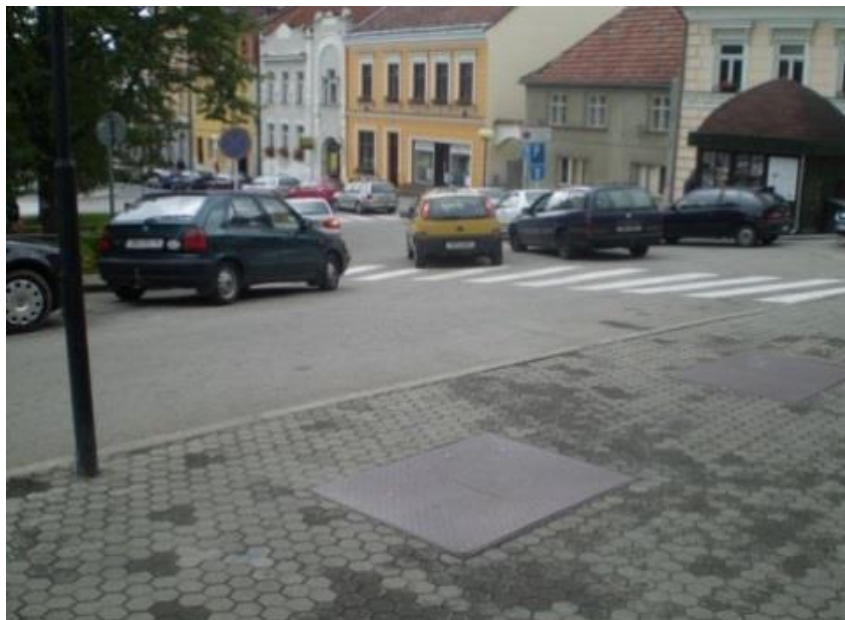
Obr. 1 - Horní část Žižkova náměstí před realizací projektu
