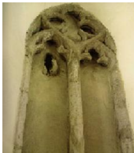
Obr. 42 Zazděné gotické okno
