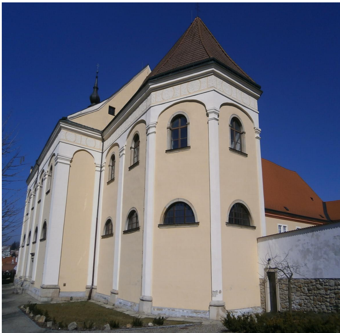
Exteriér klášterního kostela sv. Antonína Paduánského v Dačicích, pohled na presbytář kostela
