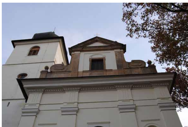
13. Kostel sv. Jiří a sv. Martina, štít hl. průčelí
