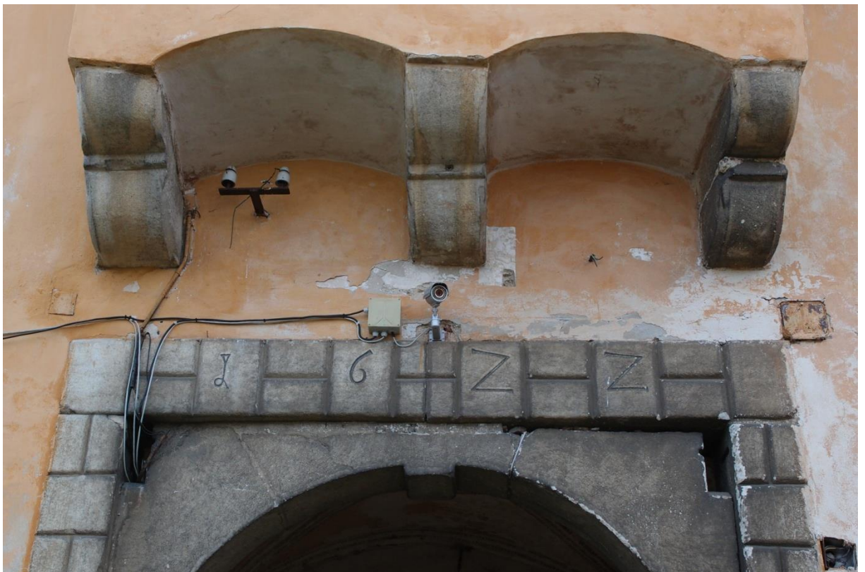
19/ Vstupní v fl, detail kamenného portálu
