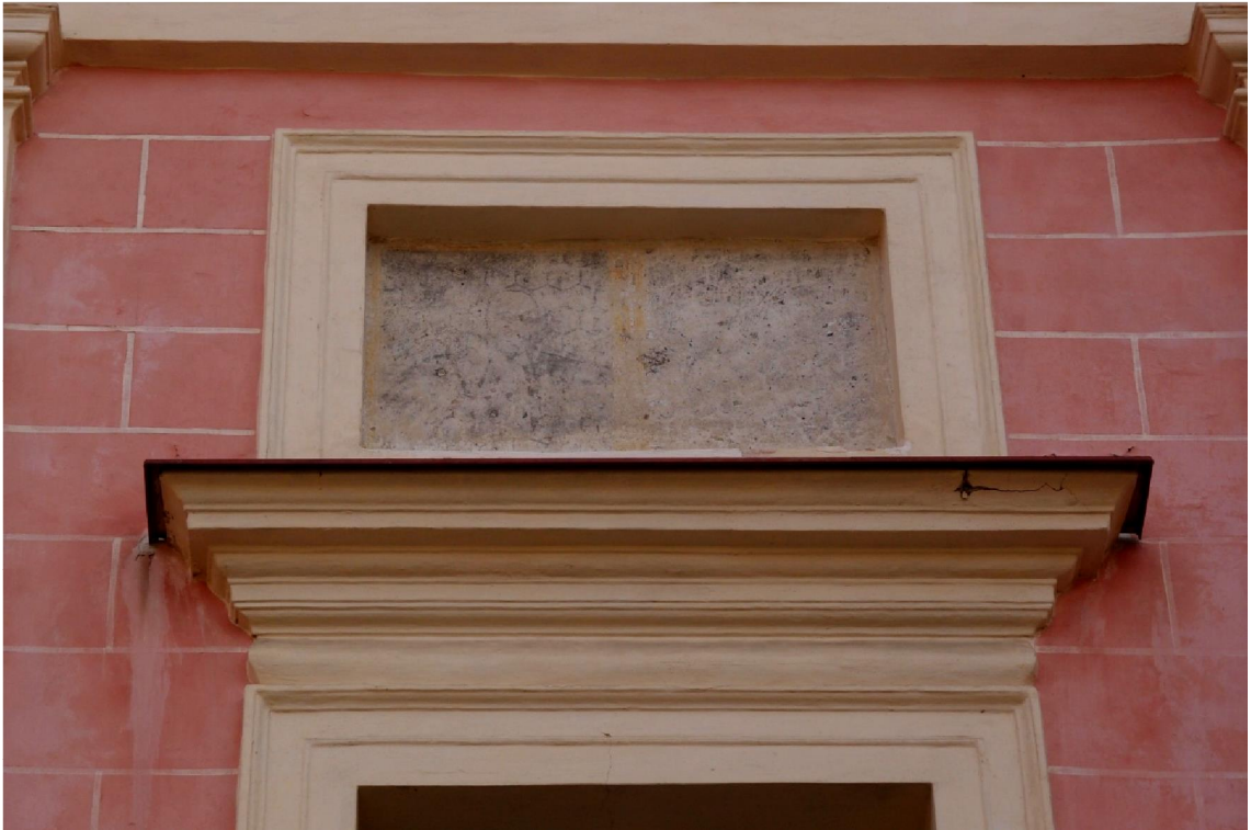
25/ Kolowratský trakt, detail slepého okna
