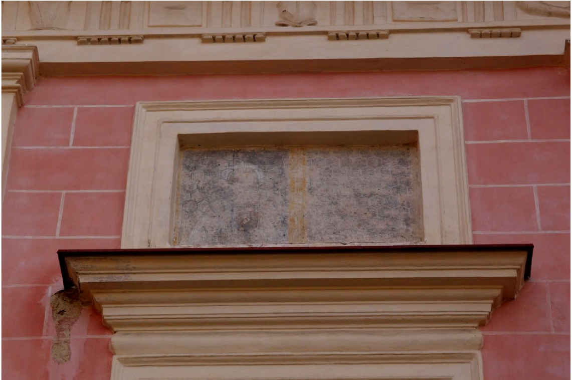
24/ Kolowratský trakt, detail slepého okna
