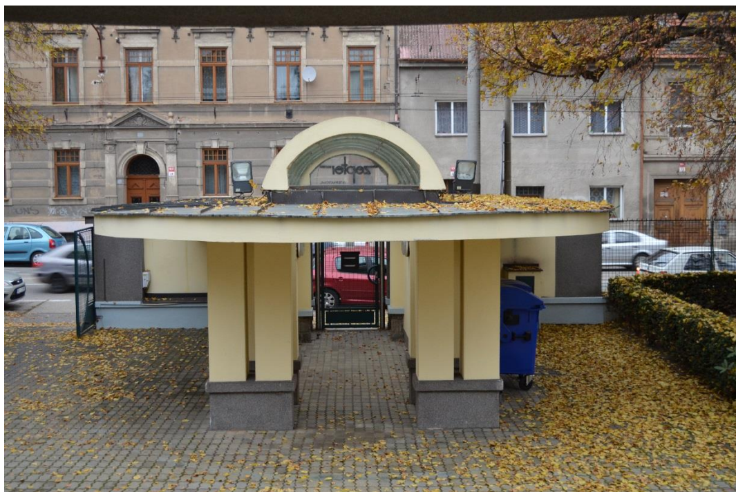
8. Přistavěná zděná chodba
