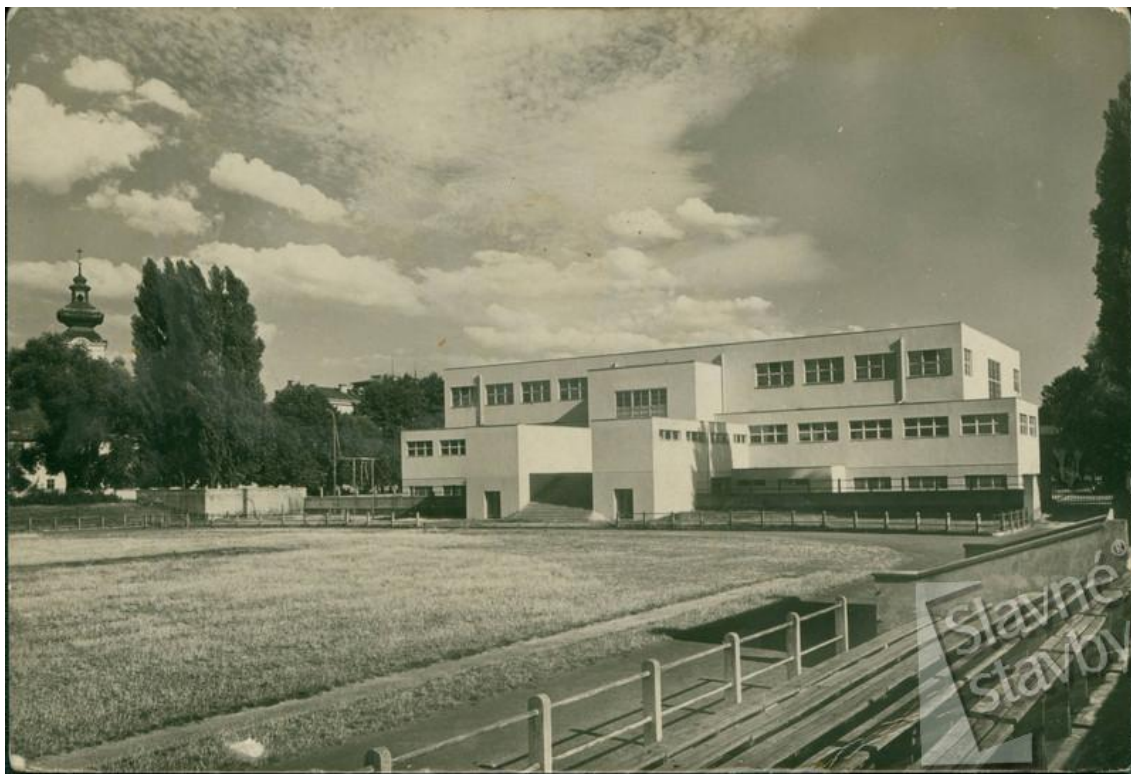
35. Dřívější pohled na sokolovnu s ještě nezastavěným schodištěm
