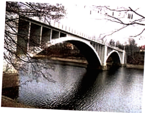
Příloha č.14: Viadukt Pastviny.
