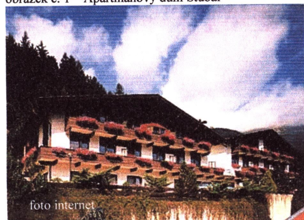
obrázek č. 1 – Apartmánový dům Stubai
