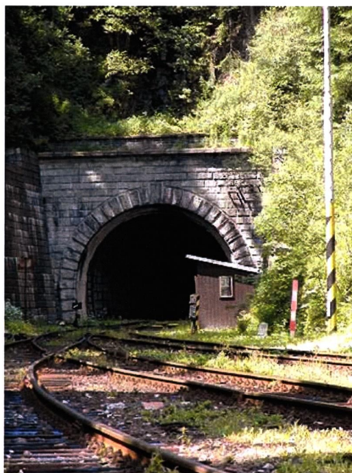
Tunel pod Špičákem
