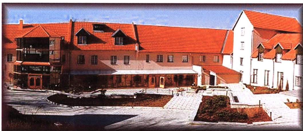
Obrázek č.7: Hotel Rustikal – celkový pohled
