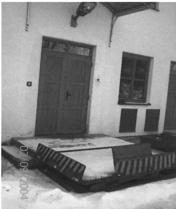
Obr. č. 1 – Nakládací rampa
