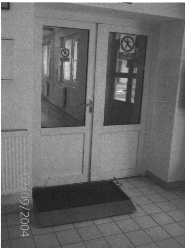
Obr. č. 2 – Vstupní plastové dveře do výrobní haly s desinfekční rohoží
