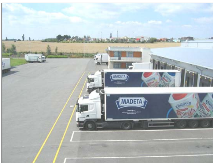
Obrázek 21 Nakládka kamionů z expedičních ramp CS Jesenice
