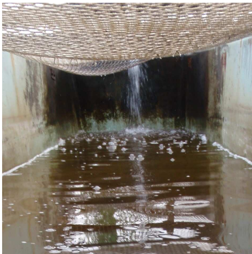
Obrázek 8-4. Neupravený přítok do žlabu s vysokou hladinou.
