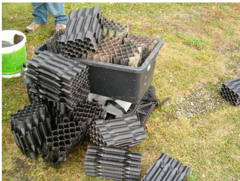
Fotografie č. 1 – Vyříznuté náplně do biofiltrů připravené k instalaci
