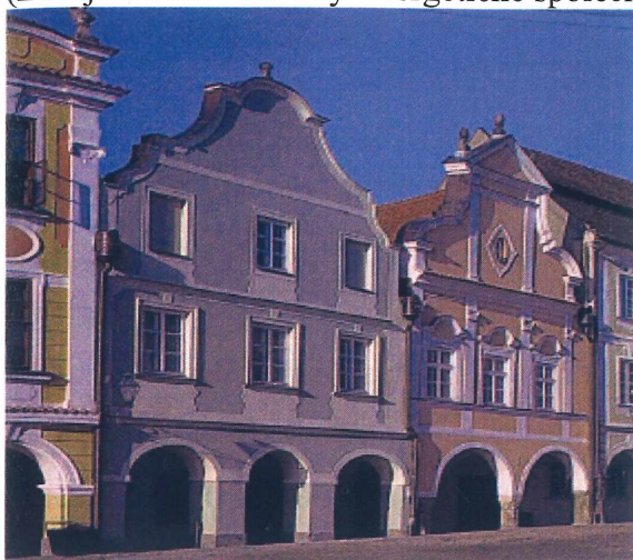
Obr. 11 Školící středisko Telč (Zdroj: Webové stránky Energetické společnosti)
