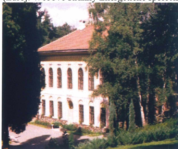
Obr. 12 Školící středisko Vlčí kopec (Zdroj: Webové stránky Energetické společnosti)
