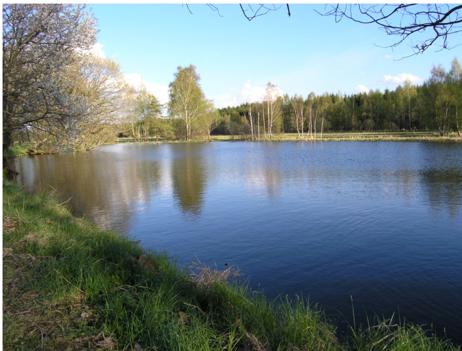
Obr.22: rybník Dvorčák - pohled od vypustního zařízení (28.4.2005)
