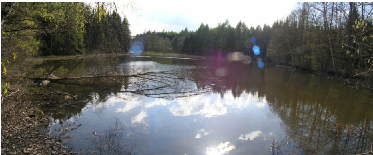
Obr 24: rybník Hejškův - foceno z výpustního zařízení (28.4.2005)
