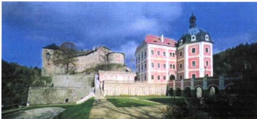
Obrázek 9 Hrad a zámek Bečov nad Teplou
