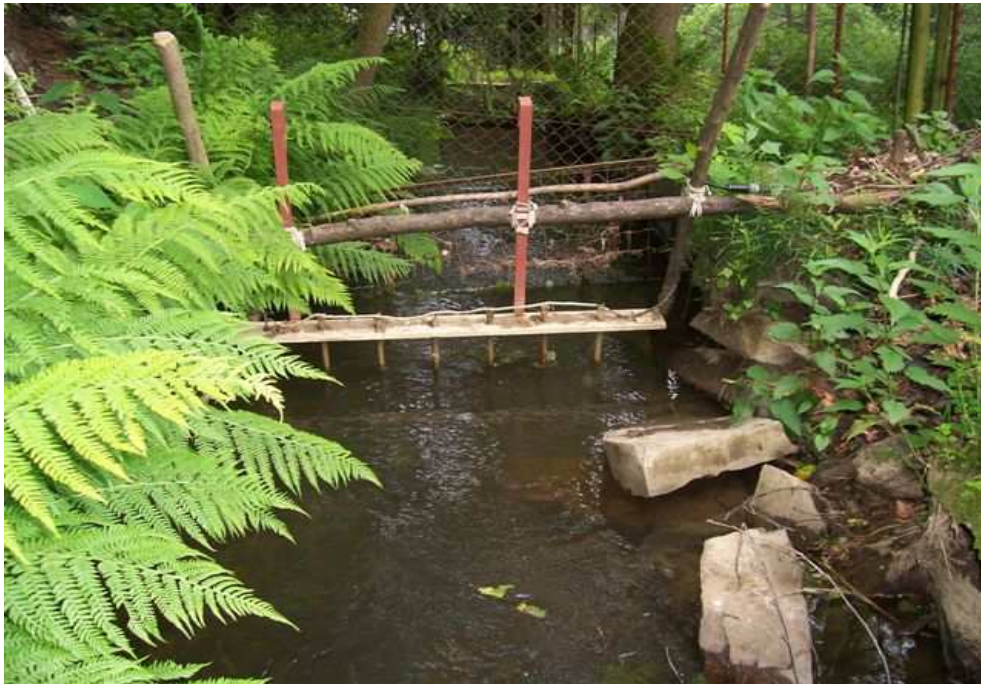
Obrázek 7-4. Zařízení nainstalované na odtoku z líhně.
