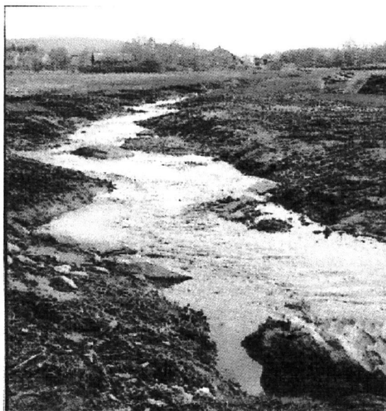
Obr.č. 6. Erozí narušené břehy Zbytinského potoka (foto T. Bendová)
