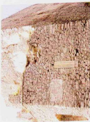
VYZDĚNÍ KAVEREN KOLEM OKNA
