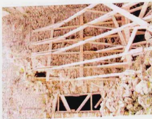
ZABEZPEČENÍ VNÍŘNÍHO SCHODIŠTĚ PROTI ALŠÍ DESTRUKCI
