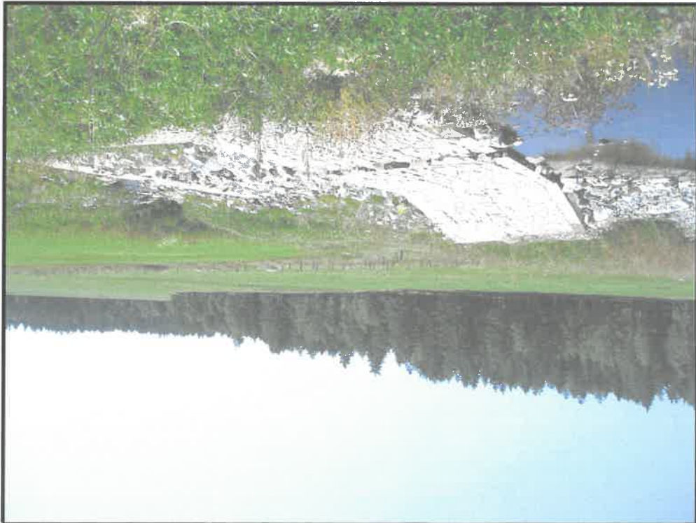
Obr. 3: Bezpečnostní přeliv s rybím přechodem na Hodňovském rybníce
