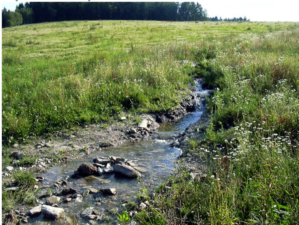
Obr.12: Nefunkční drenážní systém
