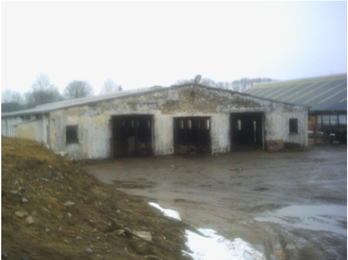
Obr. 3 Pohled na severní průčelí stáje
