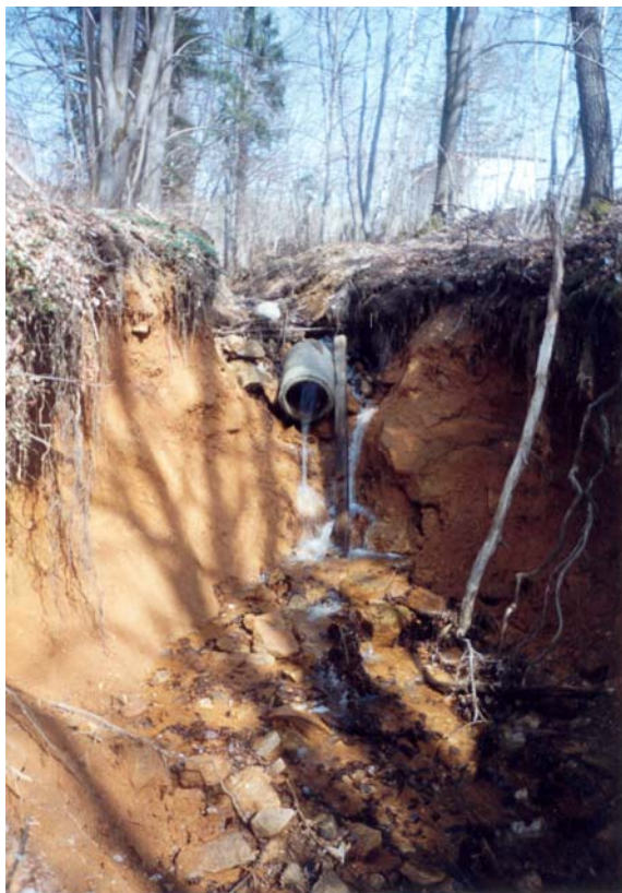
Foto č. 5,6: Tyto snímky jsou pořízeny v rozmezí dvou let jaro 2004 vlevo a jaro 2006. Je patrná velmi rychle postupující eroze.
