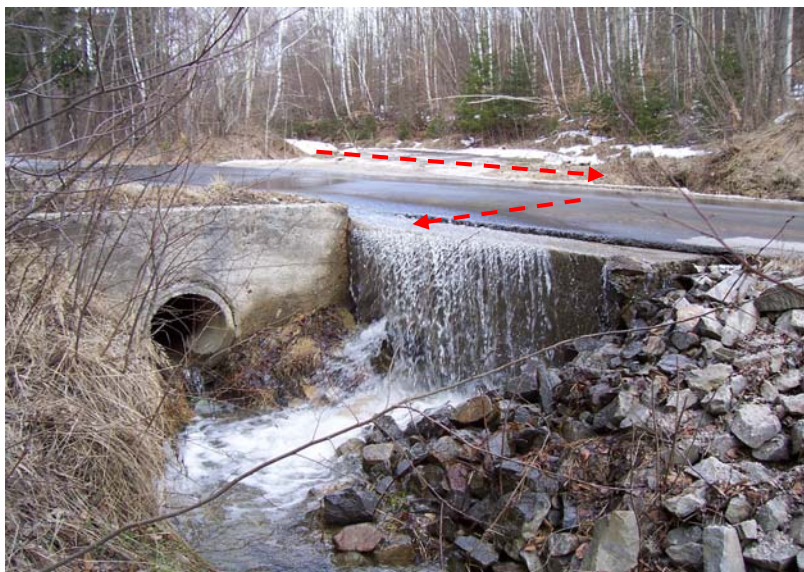
Foto č. 16: Silniční posyp zatím na svahu příkopu. Deštěm bude postupně splavován až do Zrcadlového potoka.
