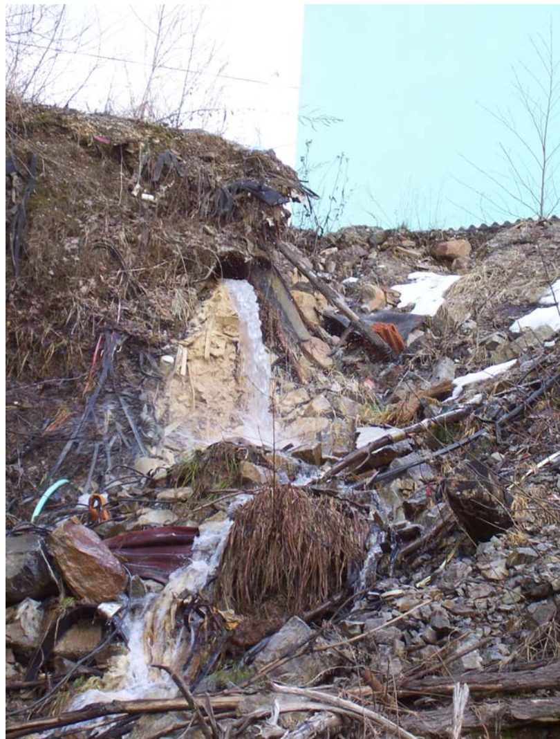
Foto č. 14: Vyústění odvodňovacího zařízení lomu Zrcadlová huť.
