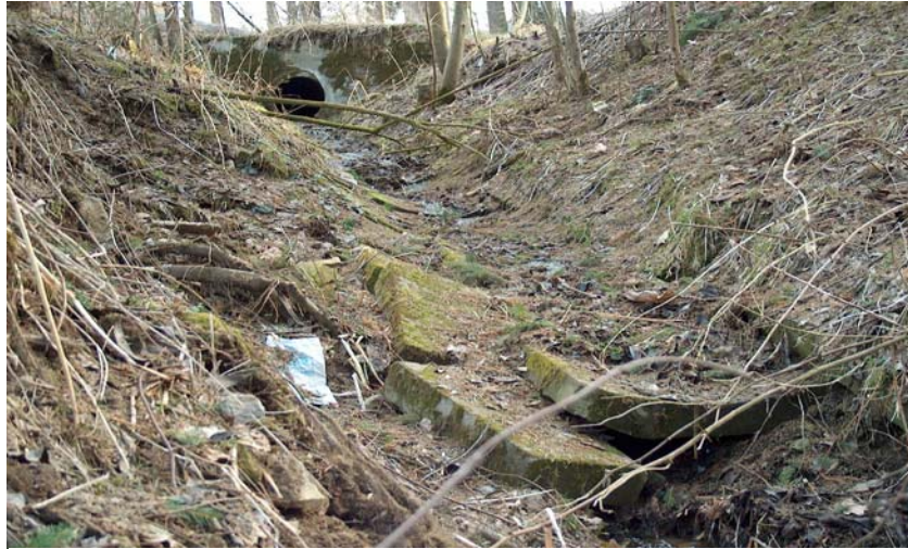
Obr. č. 6 Odvod vody zpevněným korytem v podobě žlabovek, které jsou však rozbité.
