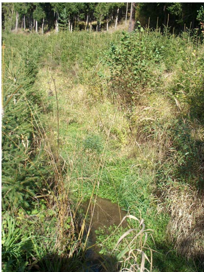
Obr. č. 12 Vybetonované, zhloubené koryto přítoku řeky Blanice, které je třeba od betonových prvků odstranit pro větší zadržetí vody v krajině.
