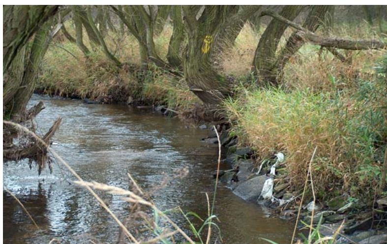
Obr. č. 24 Uvolněná fo'lie ze zpevněného koryta nevyhovuje představám o revitalizaci toku.
