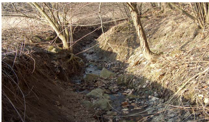
Obr. č. 8 Záchytný příkop pod svahem lesního pozemku.
