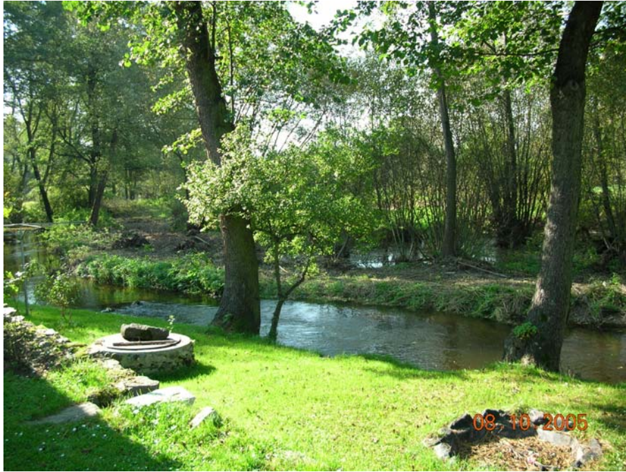
Obr. č. 27 Zlatý potok u intravilánu katastrálního území Protivec. Přes potok vede kamenný most s několika propustmi u nichž je třeba hlídat, aby se nezanášely.
