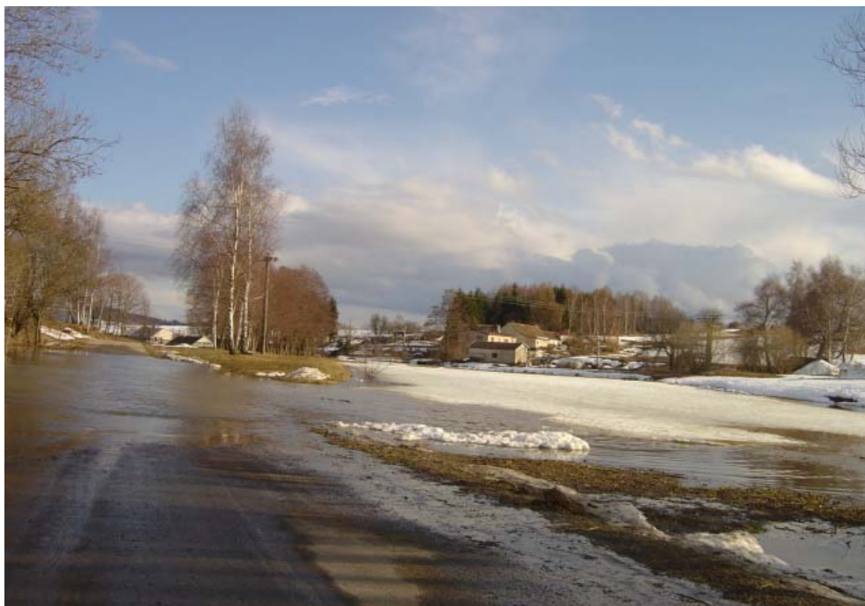
Obr. č.4 : Problémem je častý rozlivu vody na komunikaci, na pravém břehu je umístěna uzavřená skládka komunálního odpadu (snímek pořízen zařízením Sony DSC-P10)
