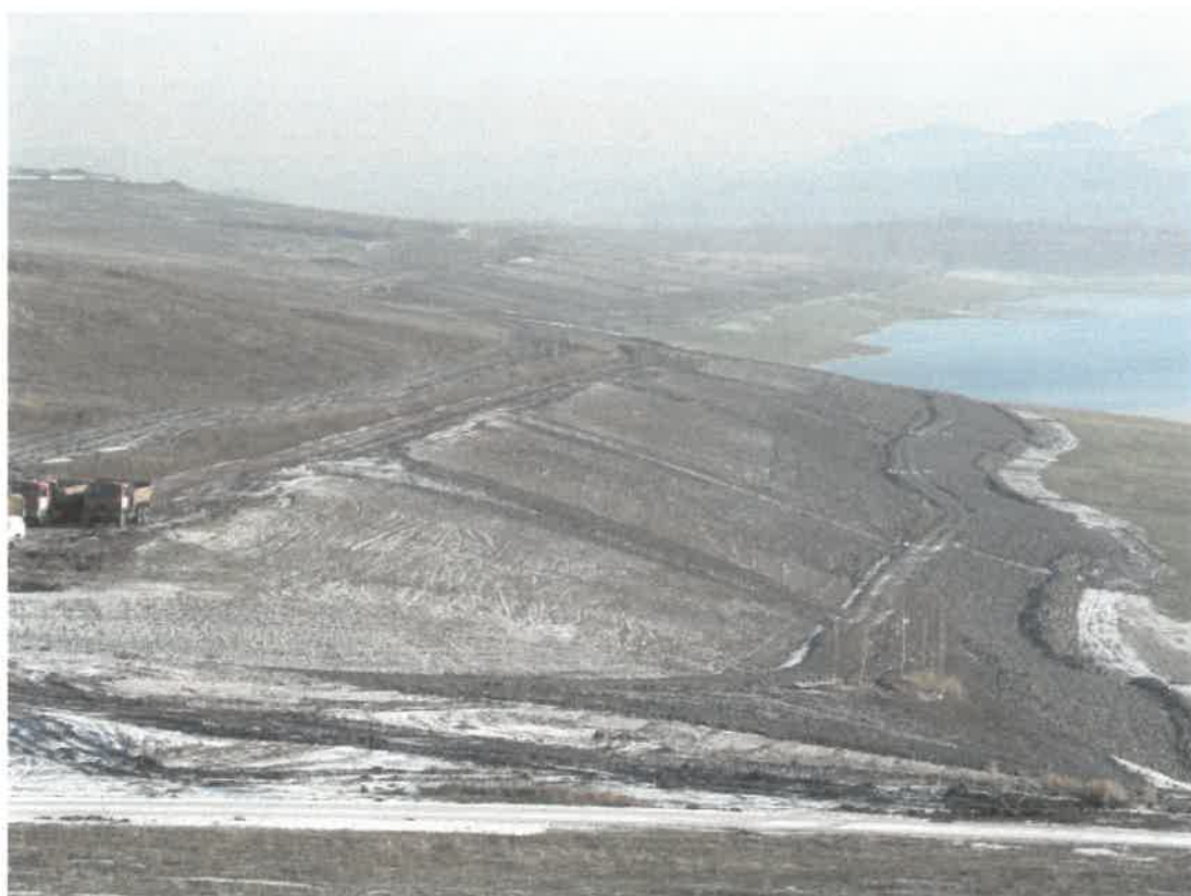
příloha č. 8 – sanace svahů prosinec 2004 (foto PKÚ, s.p.)
