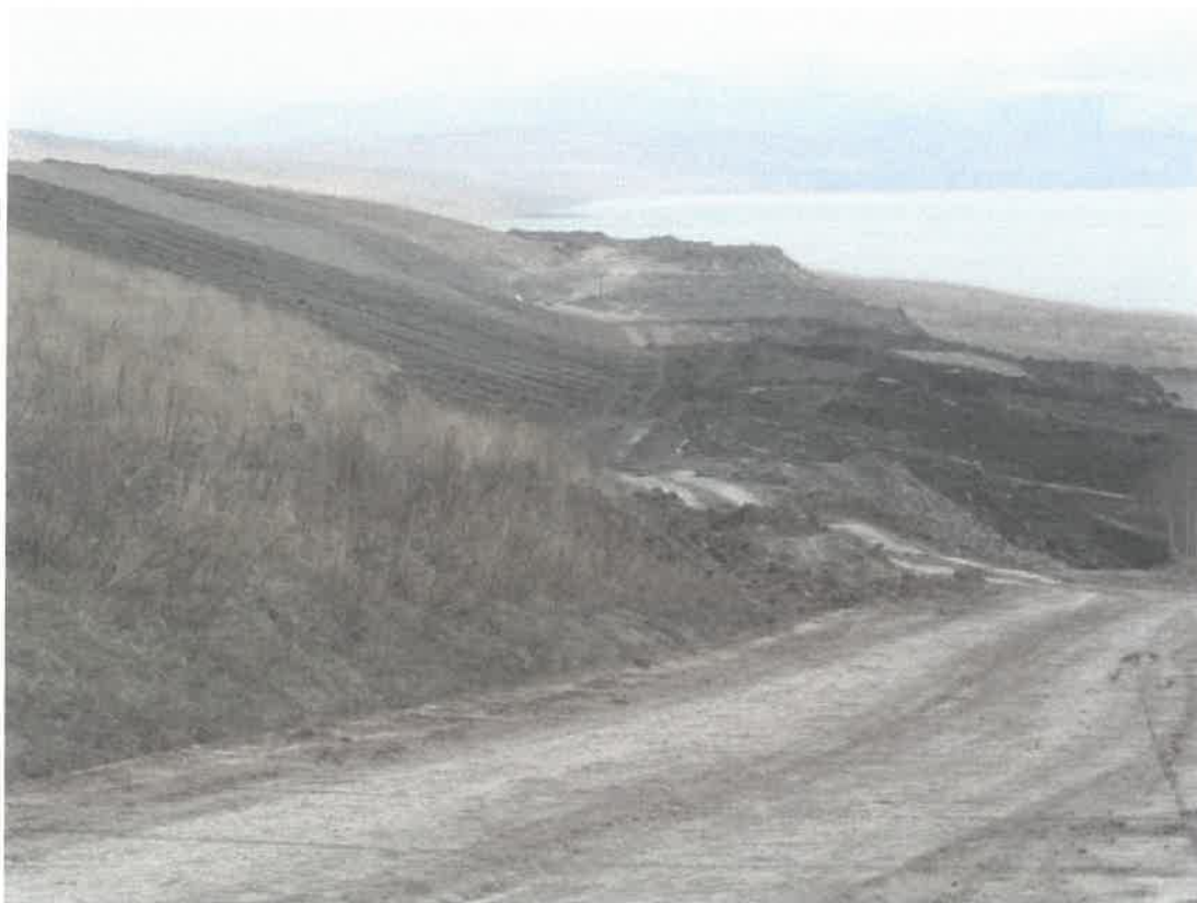
příloha č. 7 - sanace svahů jezera Chabařovice duben 2004 (foto PKÚ, s.p.)
