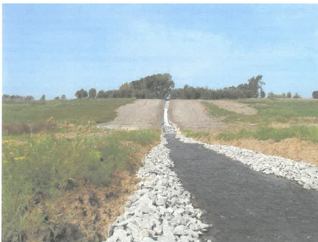
příloha č. 11 - spojovací koryto II srpen 2002 (foto PKÚ, s.p.)
