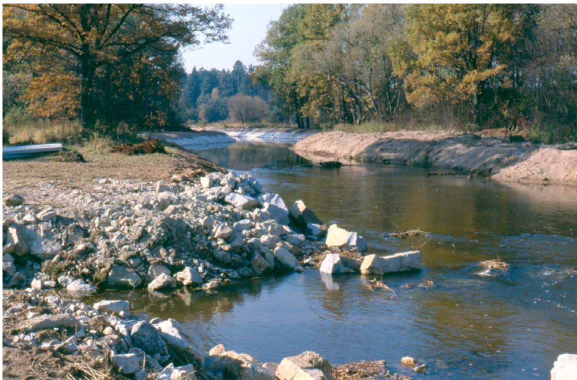
Stabilizace svahů pohozem z lomového kamene, 1985 (foto: J. Ševčík)
