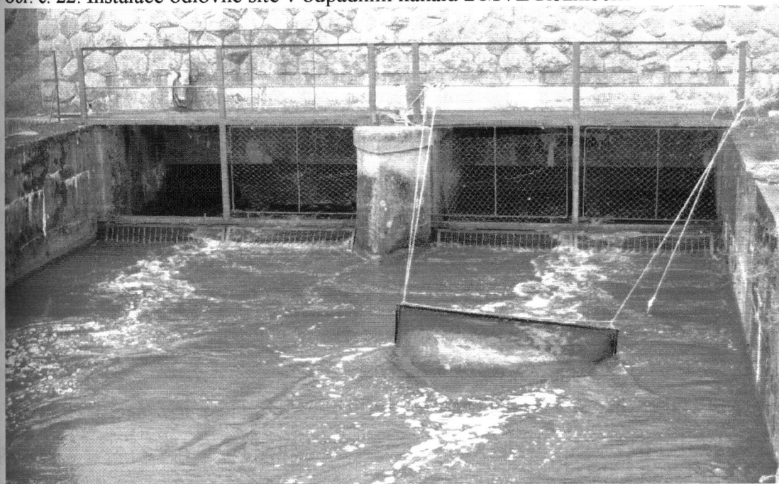
Obr. č. 22: Instalace odlovné sítě v odpadním kanálu z MVE Rožmberk
