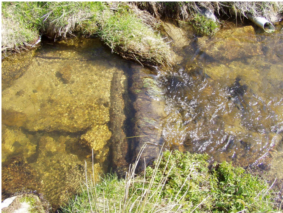
Obr. 10 - Mlýnský potok 4.5.2006, dřevěný práh se skluzem, na obrázku je rovněž vidět vyústění drenáže (foto autor)
