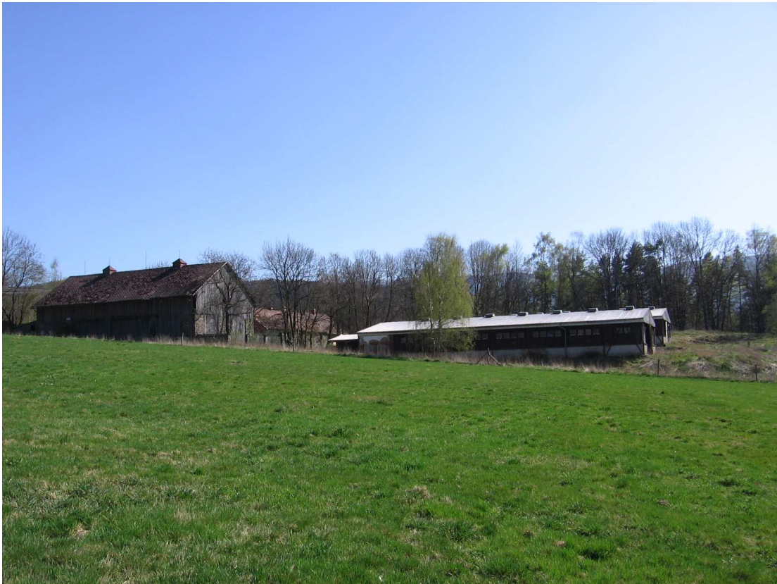
Špatův Dvůr přichystaný na rekonstrukci na penzion s jízdárnou.....
