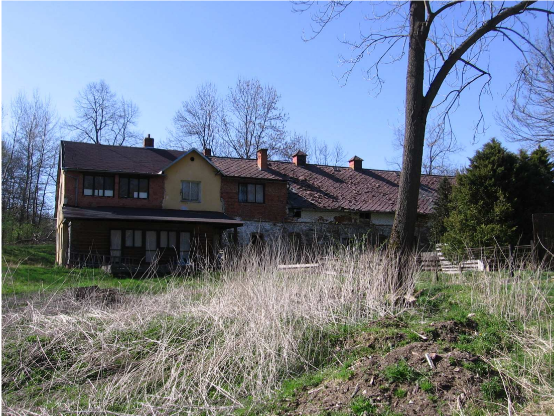
Špatův Dvůr zepředu, vše je momentálně před rekonstrukcí
