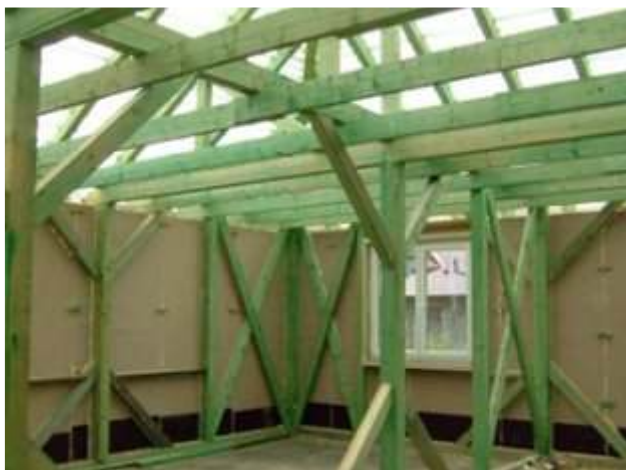
Stavba montovaného rodinného domu. Dřevěná konstrukce skeletu je oplášťována slaměnými deskami .
