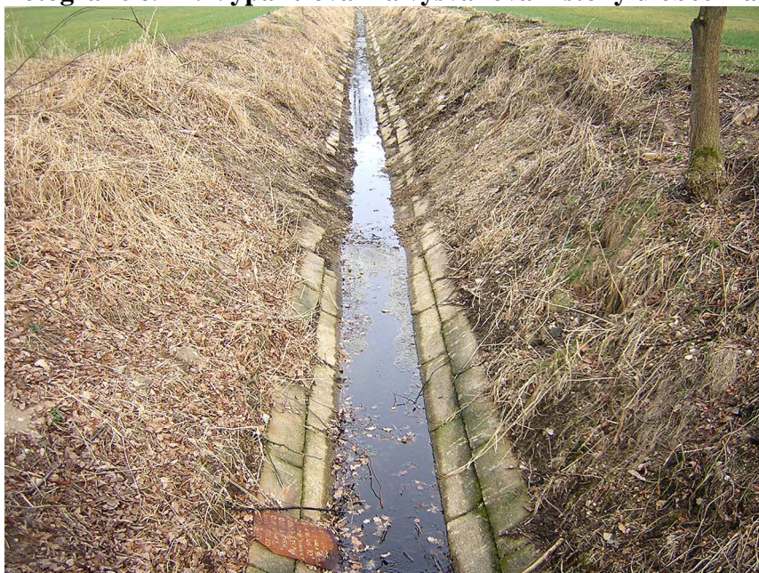
Fotografie č. 44: Vypanelování a vysvahování stoky u obce Hamr.
