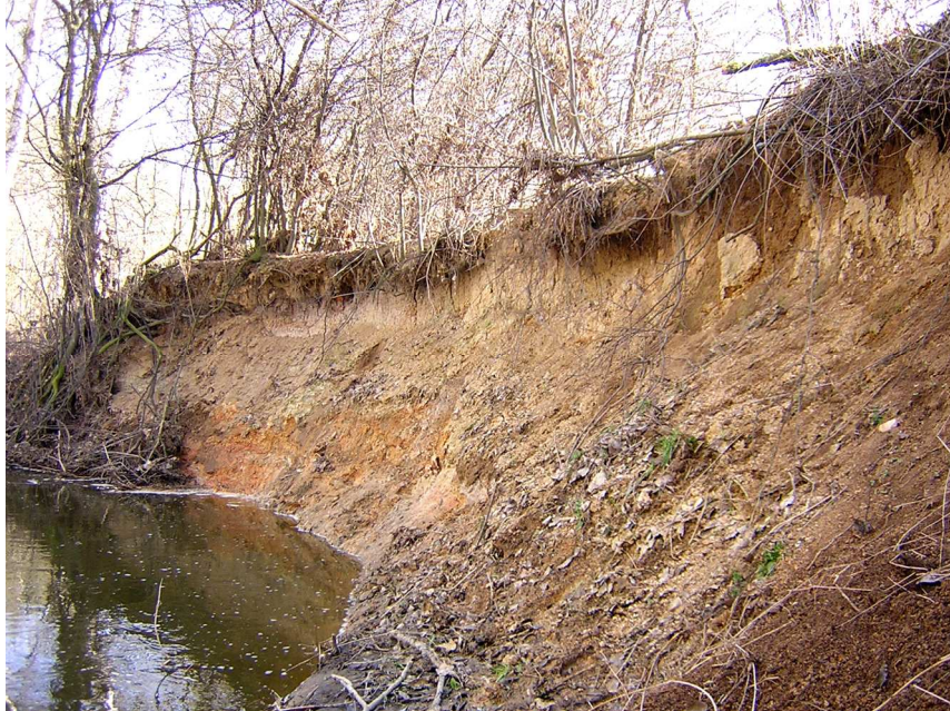
Fotografie č. 27: Stoka u rybníka Nový u Frahelže, před úpravou.
