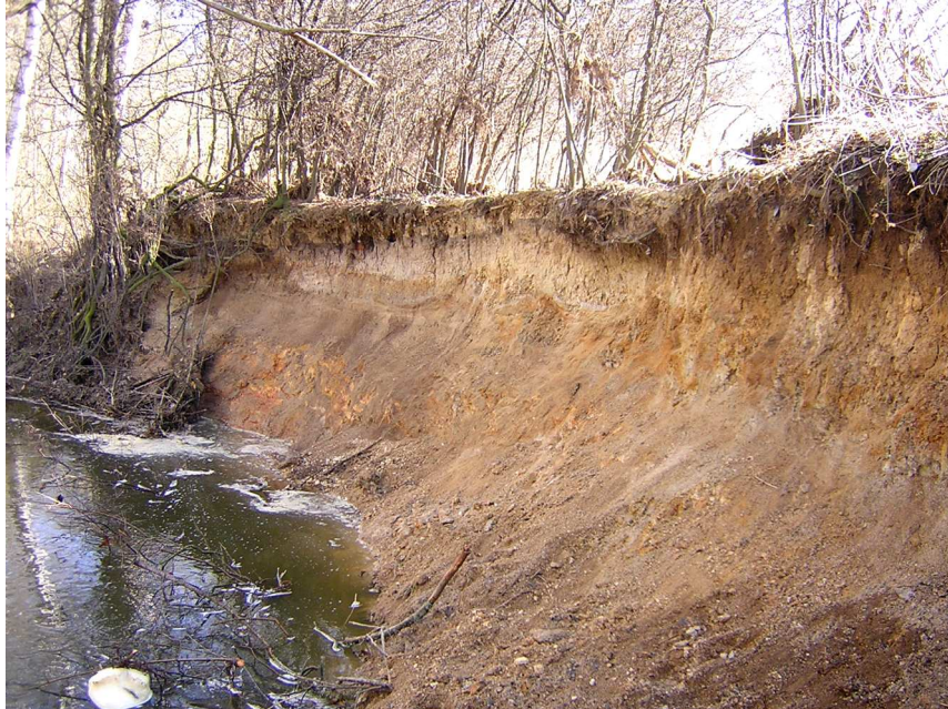
Fotografie č. 28: Stoka u rybníka Nový u Frahelže, po úpravě.
